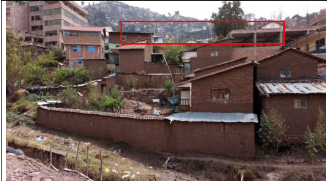
Fotografía 01: Se muestra el talud inmediato al lado Sur del área del CS San Pedro.
