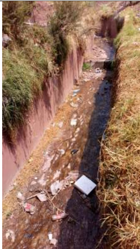
Fotografía 08: Vista aguas arriba del canal de la quebrada Picchu
