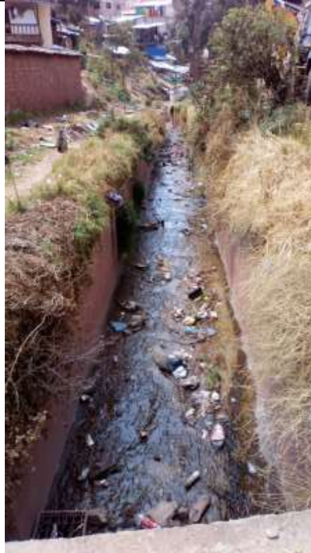
Fotografía 07: Vista aguas abajo del canal de la quebrada Picchu, esta canalización ha ayudado a la estabilización del talud debido a que frena la erosión vertical.
