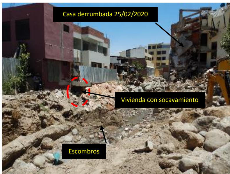
Sector Urbanización Independencia Americana, distrito Yanahuara 29/10/2020. a) Vivienda derrumbada el 25 de febrero 2020, casa con socavamiento y escombros en el cauce de la quebrada Chullo.
