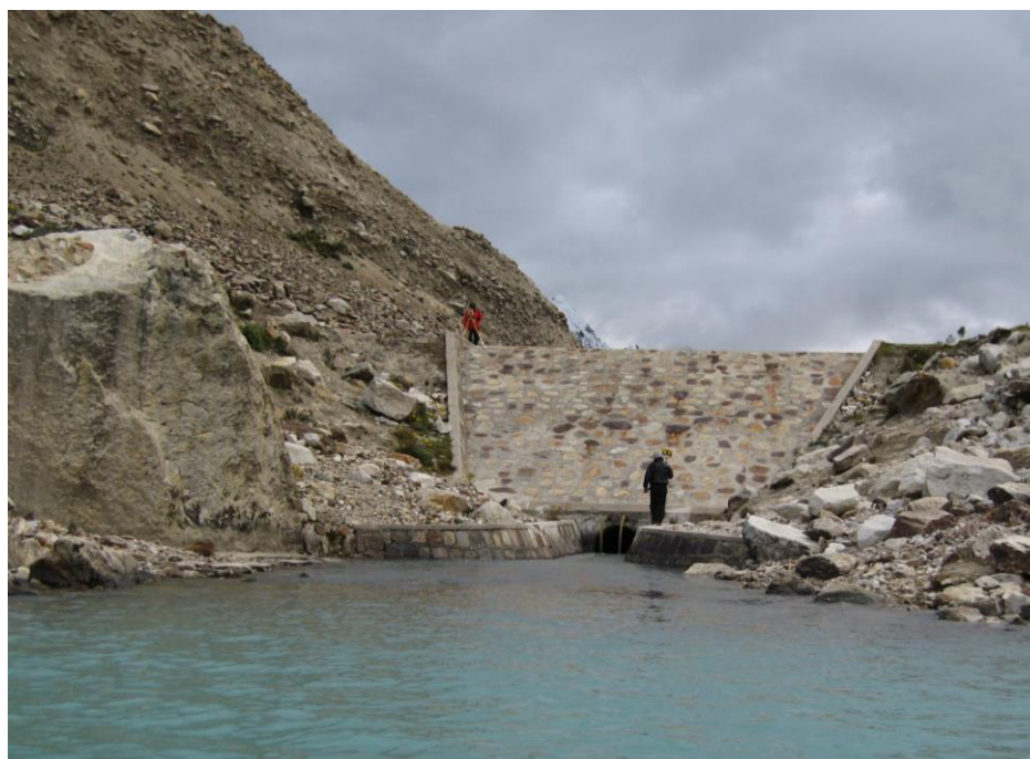
Foto N° 02.- Personal de la Unidad de Glaciología y Recursos Hídricos, realizando labores de topografía en la laguna Palcacocha.
