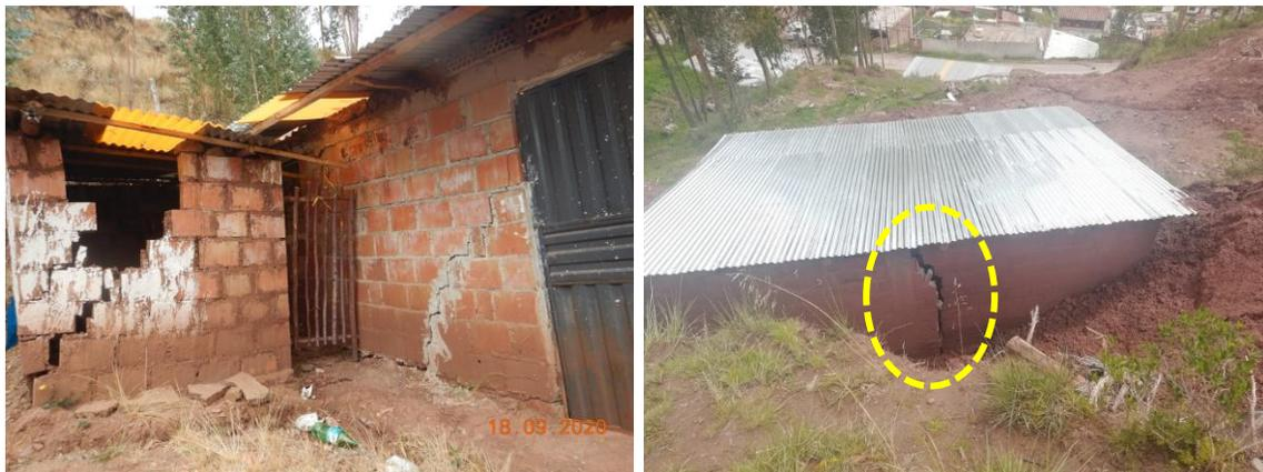
**Figura 9.** Producto del asentamiento del terreno se observó viviendas con paredes agrietadas.
