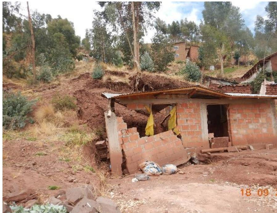
**Fotografía 7.** Vivienda colapsada producto de la reactivación de la ladera noreste del cerro Roquelloccata en derrumbe.
