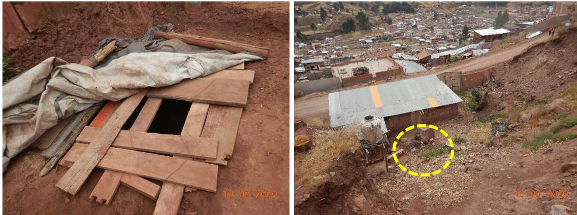
**Figura 10.** a, b) Surgencias de agua en los cortes de talud, realizado para la construcción de viviendas del sector APV 20 de Enero.
