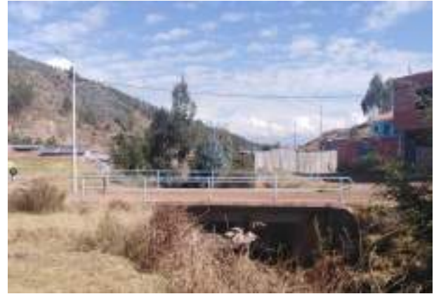
Puente de Acceso
