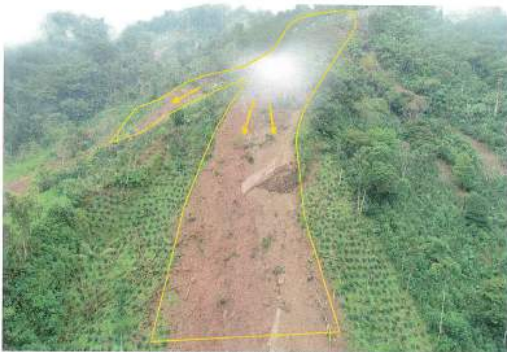
Foto 14: Deslizamiento en las laderas que se ubican en la parte alta de la subcuenca que comprende el área de estudio
