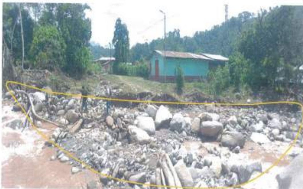
Foto 16: Materiales (bloques de roca) transportados por el cauce de la quebrada San Nicolás y depositados en ambos márgenes del río Ochque.
