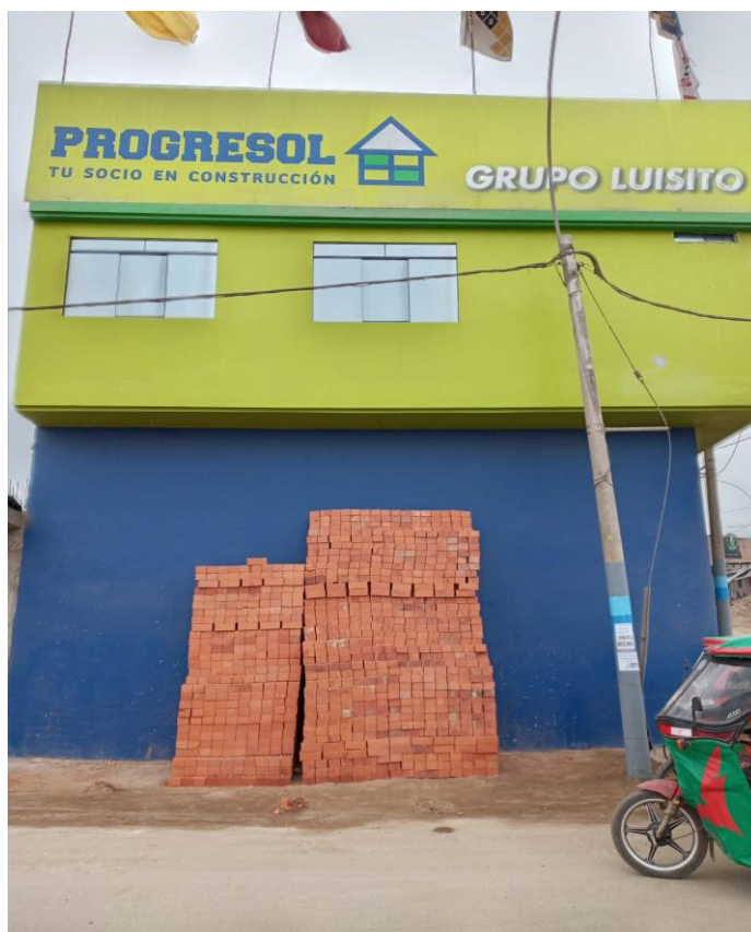
FOTOGRAFÍA N° 2. Viviendas de material Conciso, con buena base y en buen estado.
