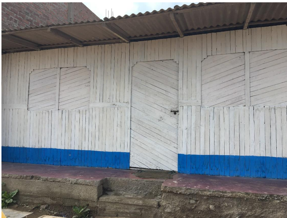
FOTOGRAFÍA N° 9. Vivienda con estructura regular, cimiento de cemento y en buen estado.
