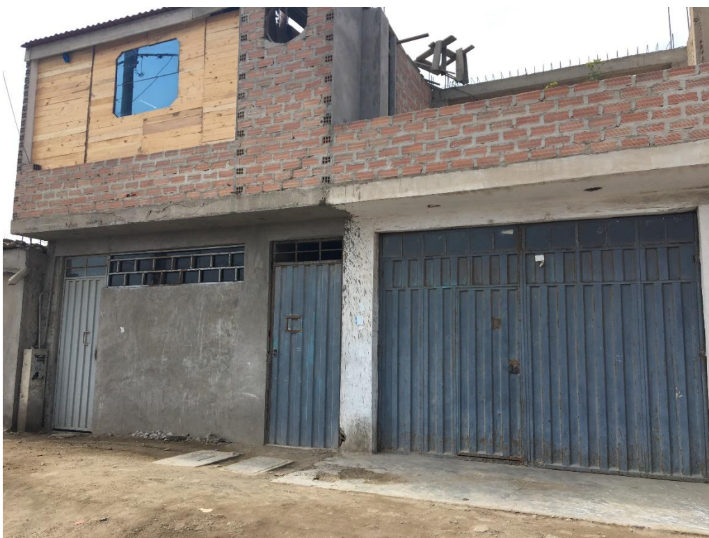
FOTOGRAFÍA N° 10. Vivienda con estructura de ladrillos y columnas, cimiento firme y en un buen estado de construcción.
