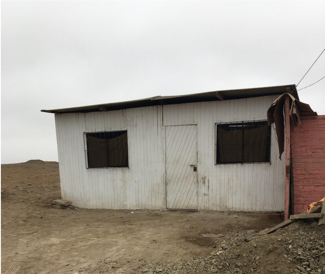
FOTOGRAFÍA N° 15. Vivienda con construcción regular, cimiento firme, construcción de esteras y madera.
