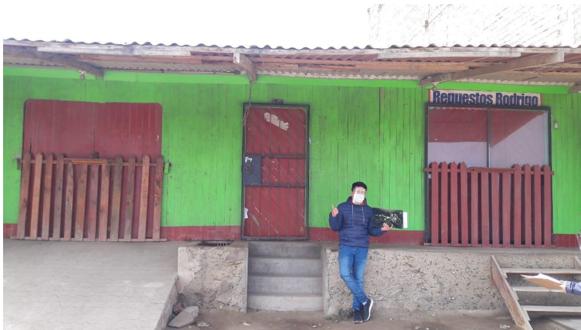
FOTOGRAFÍA N° 8. Vivienda con estructura regular, cemento de cemento y en buen estado.
