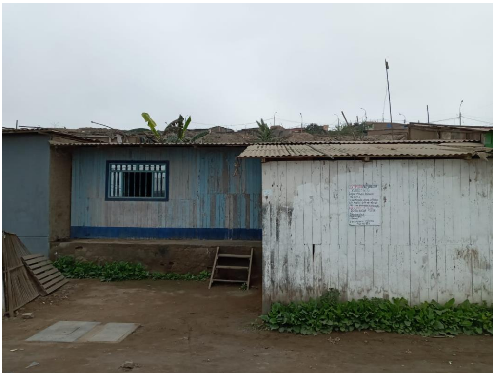
FOTOGRAFÍA N° 6. Vivienda en estado regular con cimiento de cemento en condiciones aptas.
