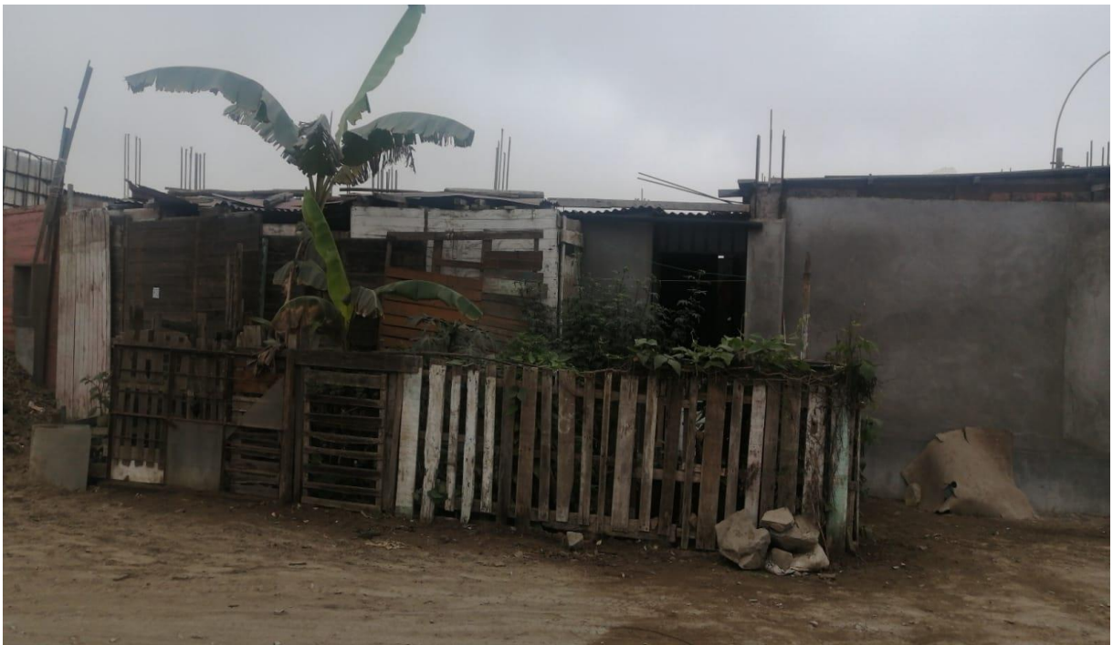
FOTOGRAFÍA N° 14. Vivienda con construcción regular, cimiento firme, construcción de ladrillo y esteras.
