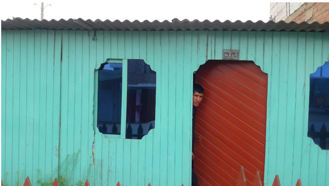
FOTOGRAFÍA N° 3. Vivienda de material madera, no tienen cimentación y mantiene buen estado.
