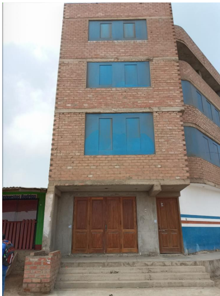
FOTOGRAFÍA N° 7. Vivienda con estructura firme, materiales resistentes y con cemento de cemento.
