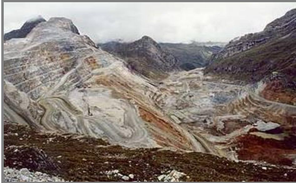
Foto Nº 33: Antamina es una mina con método explotación a tajo o cielo Abierto ( open pit )
