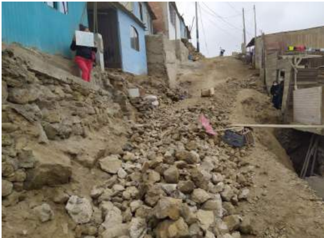
Vista del Pasaje L entre las manzanas R' y S', lado derecho e izquierdo respectivamente.
