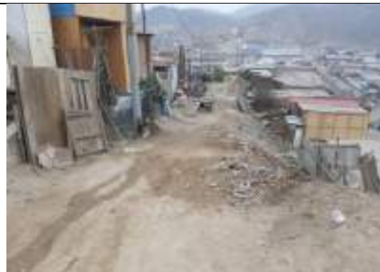
Vista de la Calle M donde se visualiza la Mz. C', lado izquierdo.
