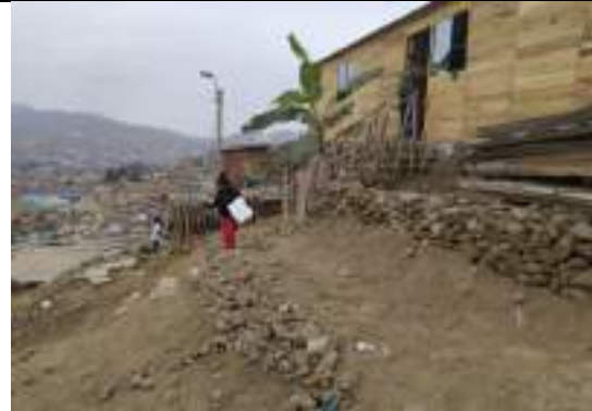
Vivienda de la Mz. R' Lt. 9 apoyada sobre pirca.
