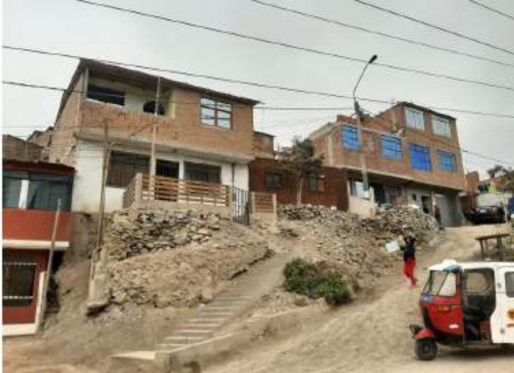
Vista de las viviendas de la Mz B' Lt 9 (3 pisos) , 10 (2 pisos), 11 (1 piso) y 12 (2 pisos), empezando desde la derecha.
