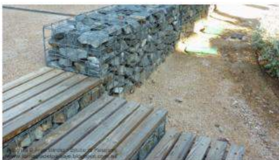
Ilustración 2. Muro de gaviones a implementar.
