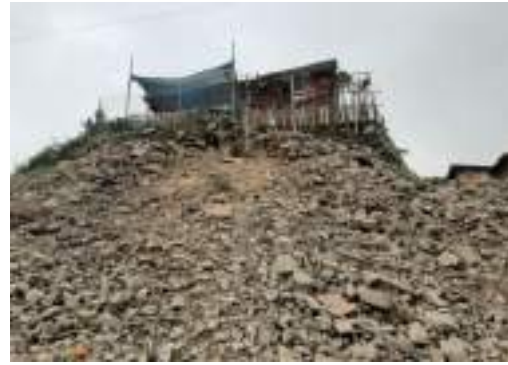
Vivienda de la Mz E2 Lt. 11 cercana a desnivel del terreno.
