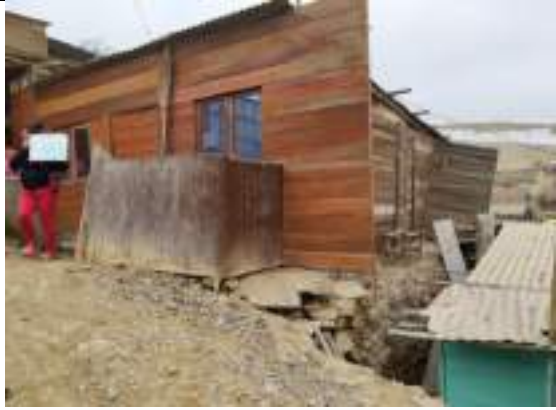
Vivienda de la Mz. A' Lt. 1 apoyada sobre pirca.
