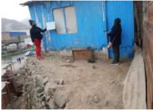
Vivienda de la Mz. E2 Lt. 10, cerca a desnivel.
