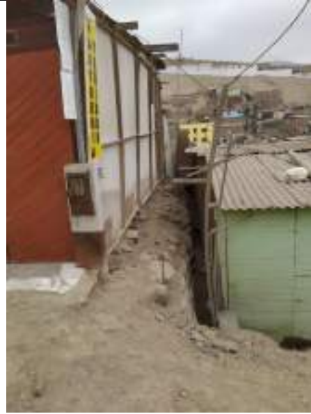
Vivienda de la Mz. A' Lt. 4 apoyada sobre neumáticos.
