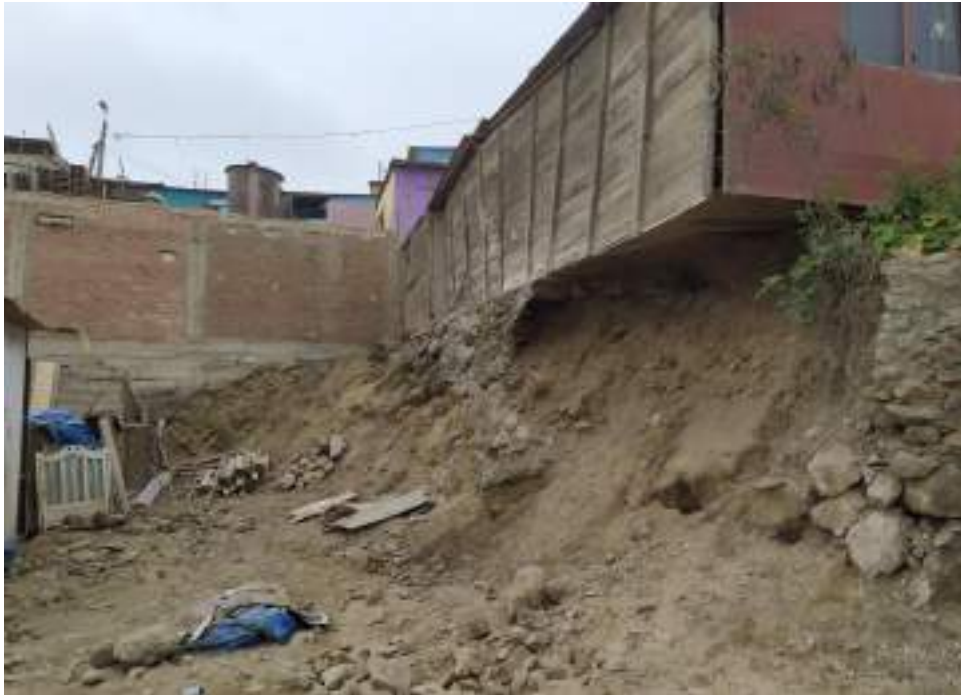
Parte posterior de la vivienda de la Mz. R' Lt. 4 con base inestable y con riesgo muy alto.
