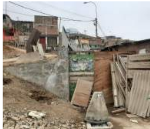
Fotografía tomada desde el Pasaje 1, donde se aprecia un muro de contención entre la Calle 2 y la vivienda de la Mz. I' Lt. 8
