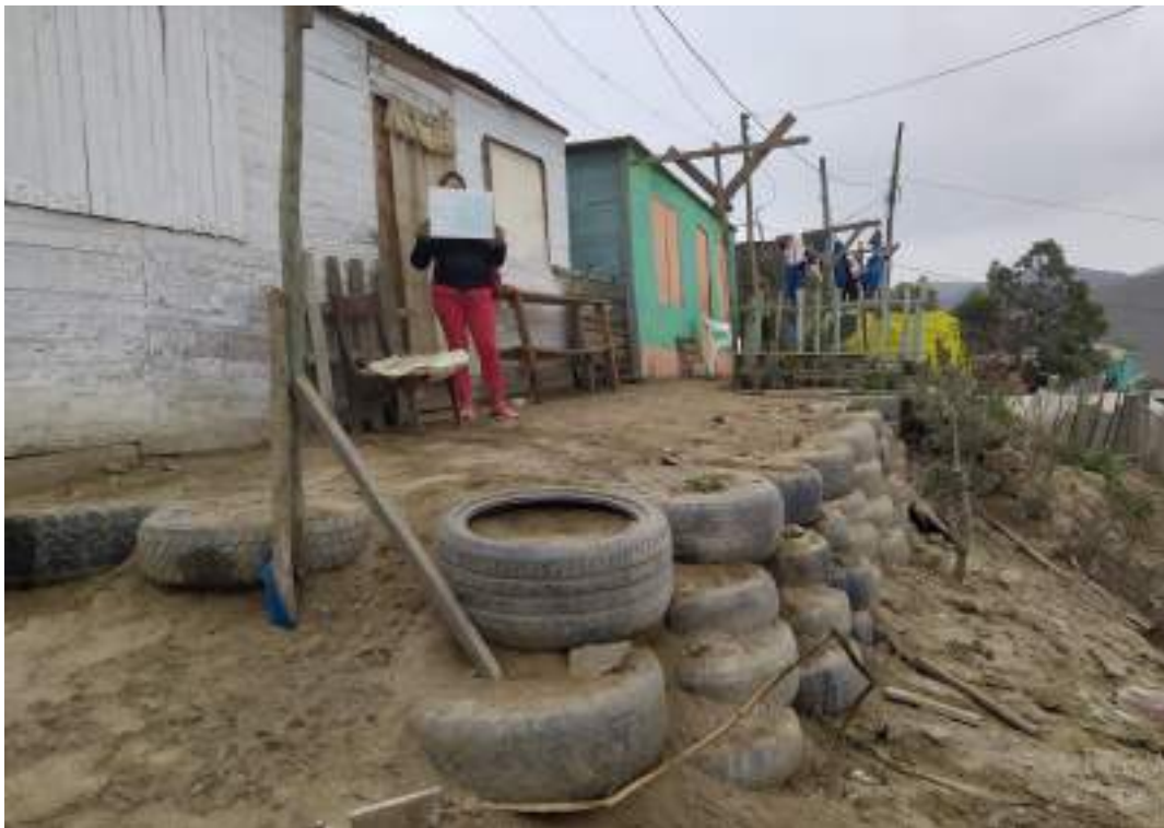
Vista de la manzana E', del lado izquierdo, donde se aprecia que parte del pasaje J se apoya sobre neumáticos.
