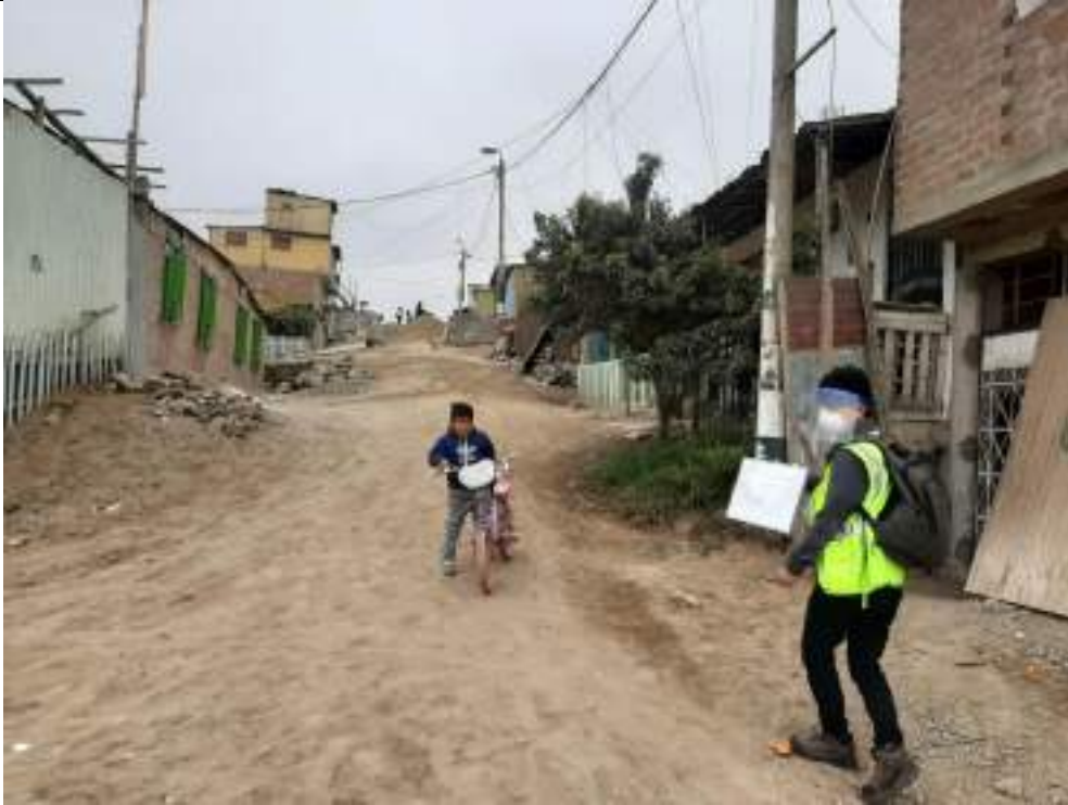
Vista de la Manzana I', lado derecho, desde el Pasaje 1
