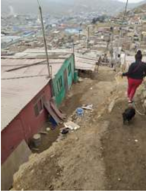
Vista de la Mz. D', lado derecho, tomada a la altura de la vivienda Mz. D' Lt. 19 desde la Calle F.
