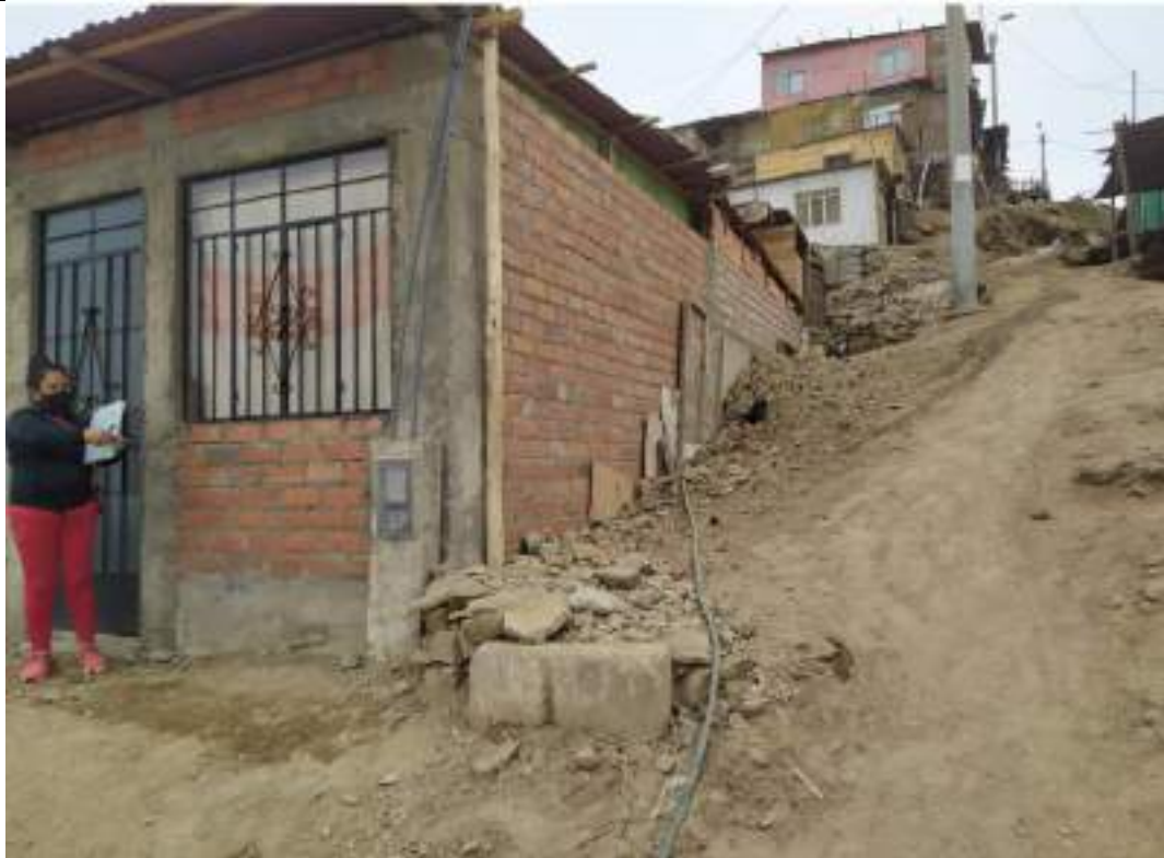
Vista de la Calle F tomada desde la Mz. E' Lt. 1 cruce con el Pasaje J
