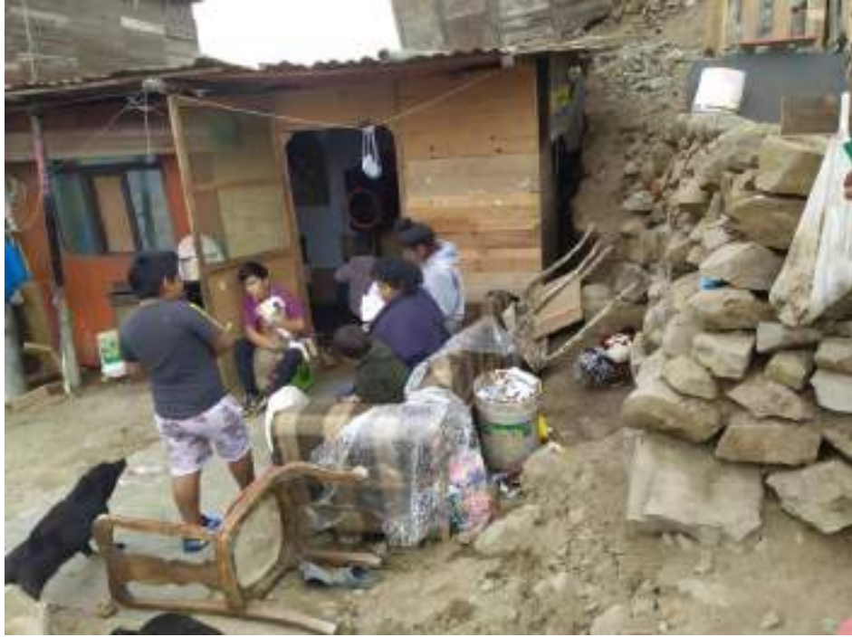
Vista de las viviendas de la Mz. R' Lt. 9 y 10 (derecha e izquierda respectivamente). Donde se aprecia posible riesgo de deslizamiento de tierra que afectaría a la vivienda del Lt. 10.
