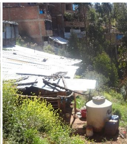
Fotografía 2: Pileta de agua que abastece a 2 manzanas.
