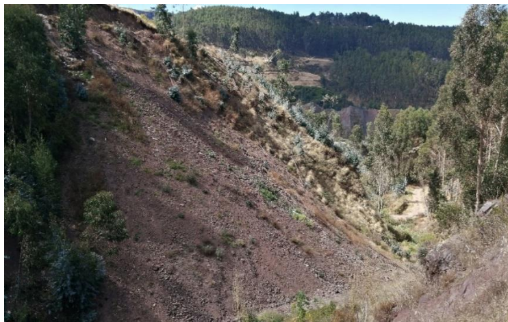
Fotografía 21.- Ladera fuertemente empinada tomada al extremo noreste del área ZRECU02.
