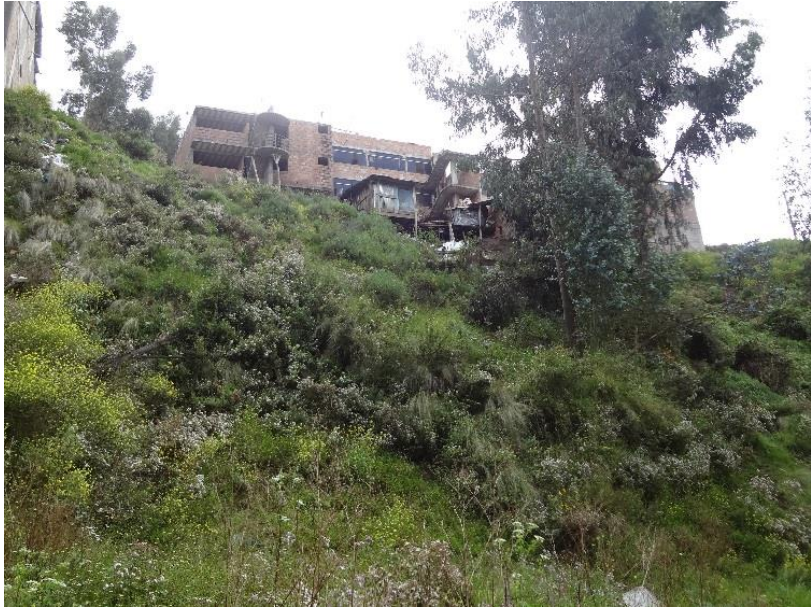
Fotografía 15: Pendientes escarpadas a fuertemente empinadas mayores a 37° formadas en la ladera izquierda del área de estudios Fuente: Equipo Técnico PM 41 ZRE.
