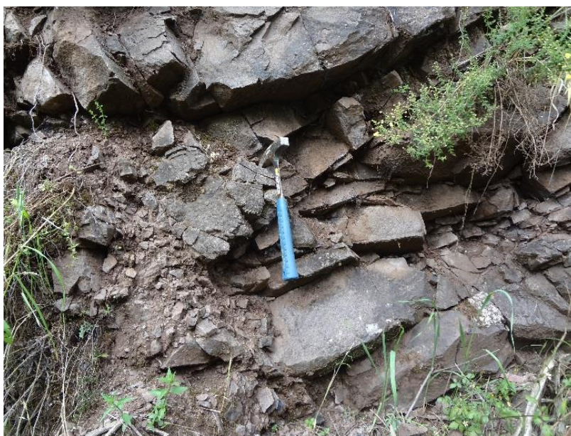
Fotografía 7: Estratos de roca microconglomeradica fracturados, Se observa las fracturas casi paralelas con juntas sin relleno. Fuente: Equipo Técnico PM 41 ZRE
