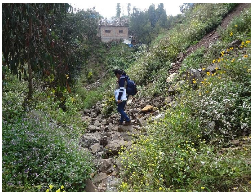
Fotografía 8: Material de relleno depositado en el cauce natural de la quebrada, se observa fragmento de roca extraída de los taludes, con fines urbanos
