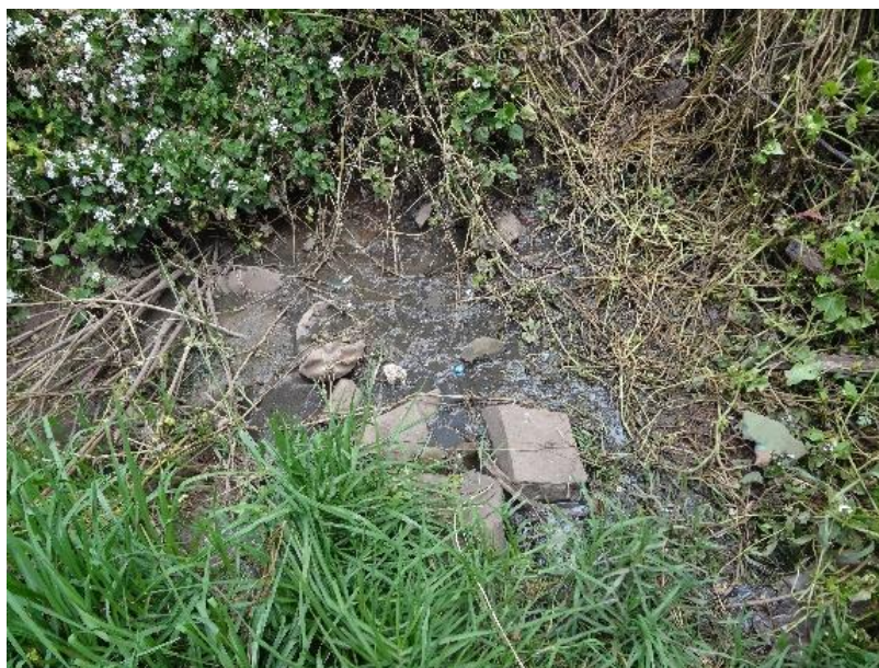
Fotografía 13: Cauce aluvial relleno de escombros y aguas residuales
