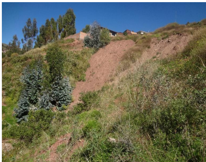
Fotografía 13: Laderas fuertemente empinadas en planos de deslizamiento de suelos
