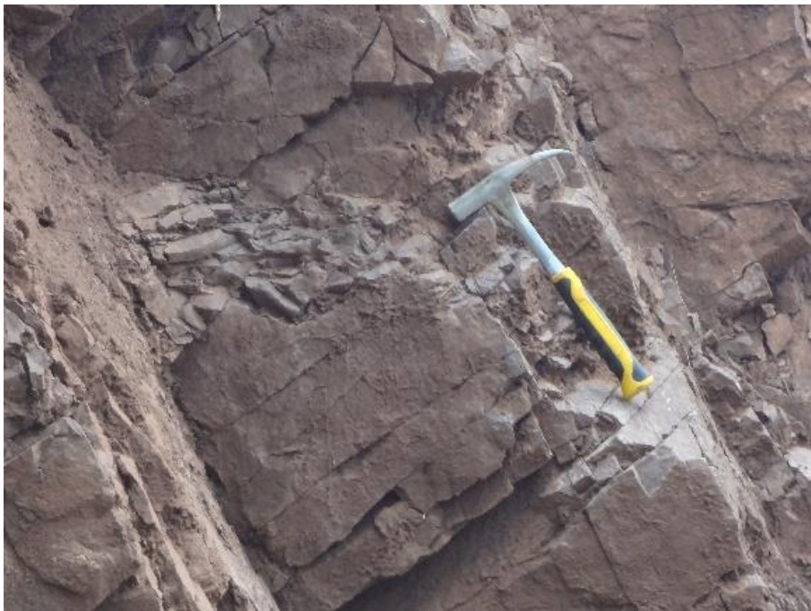
Fotografía 8: Roca Areniscas muy fracturadas, fracturas perpendiculares con suelo en las juntas
