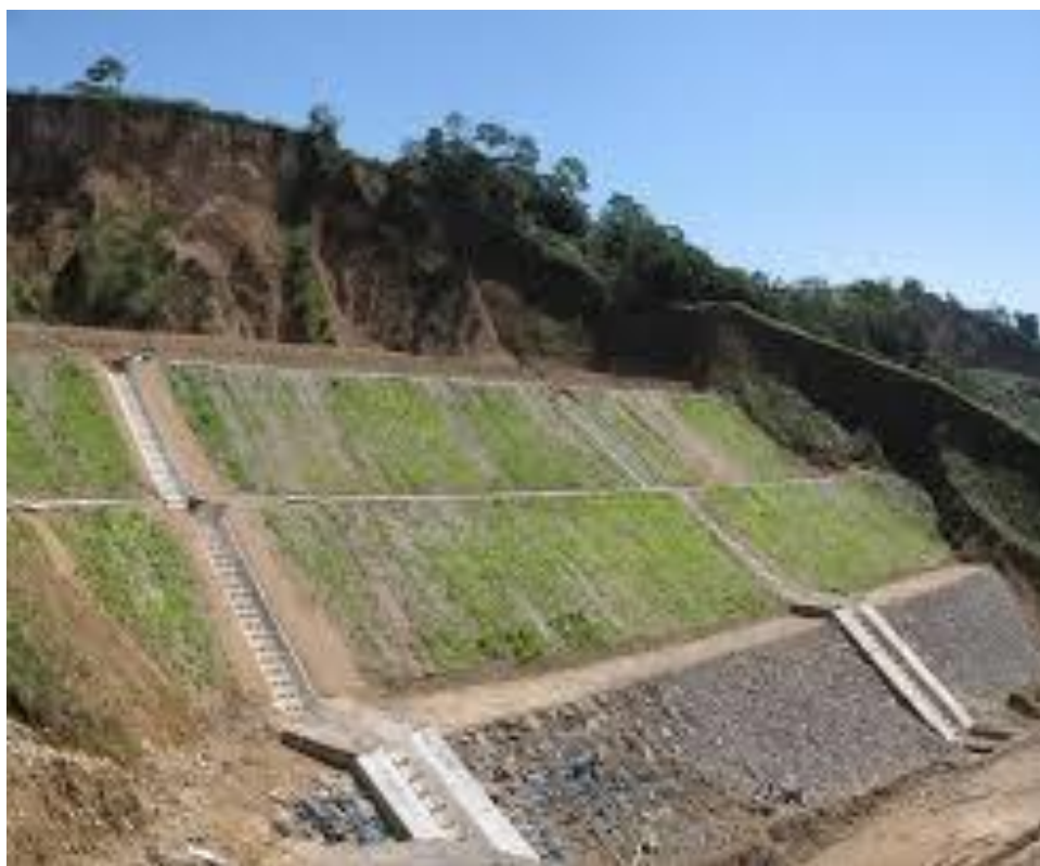
Imagen N° 14 Conformación de la superficie del terreno.
