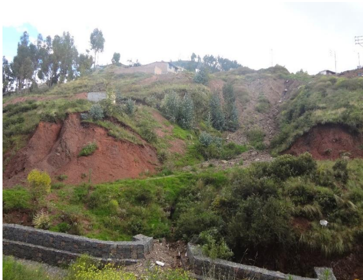
Fotografía 23.- Material de relleno, tomada extremo sur del área ZRECU01.
