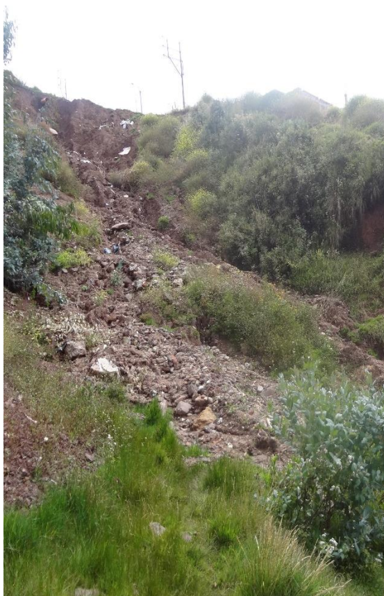
Fotografía 5: desmonte vertida erosionado hacia la quebrada
