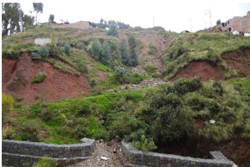
Fotografía 10: Material de relleno depositado en el cauce natural de la quebrada, se observa fragmento de roca extraída de los taludes, con fines urbanos
