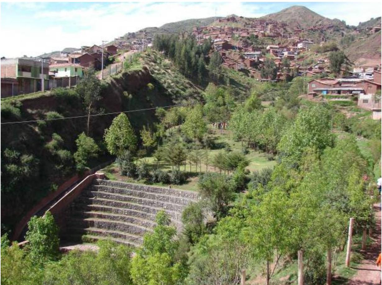
Combinación de muro de contención o contrafuerte en el pie de deslizamiento activo (con gaviones) y canalización de quebrada en la margen derecha (vista aguas arriba).
