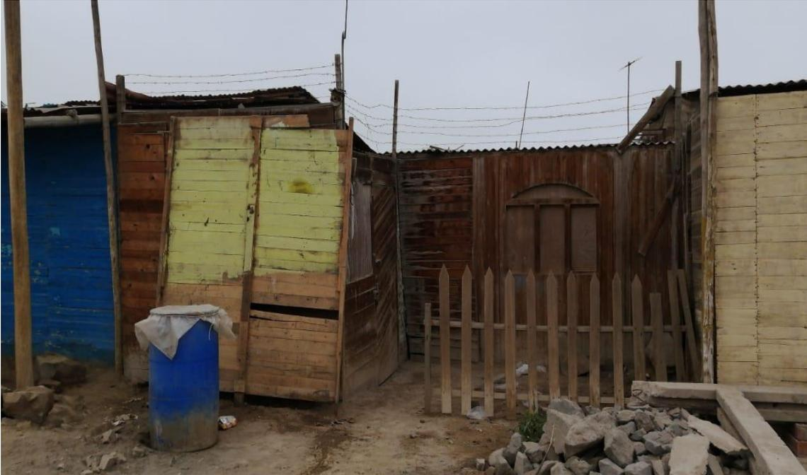
FOTOGRAFÍA N° 11. Mz. U, lote 6, vivienda de material de madera, no cuenta con cemento y se encuentra en malas condiciones.
