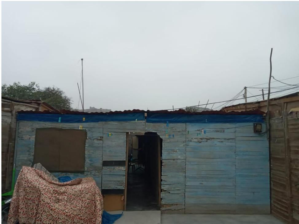
FOTOGRAFÍA N° 6. Mz. T, Lote 34, vivienda de material de madera, cimiento firme no se encuentra en buen estado.
