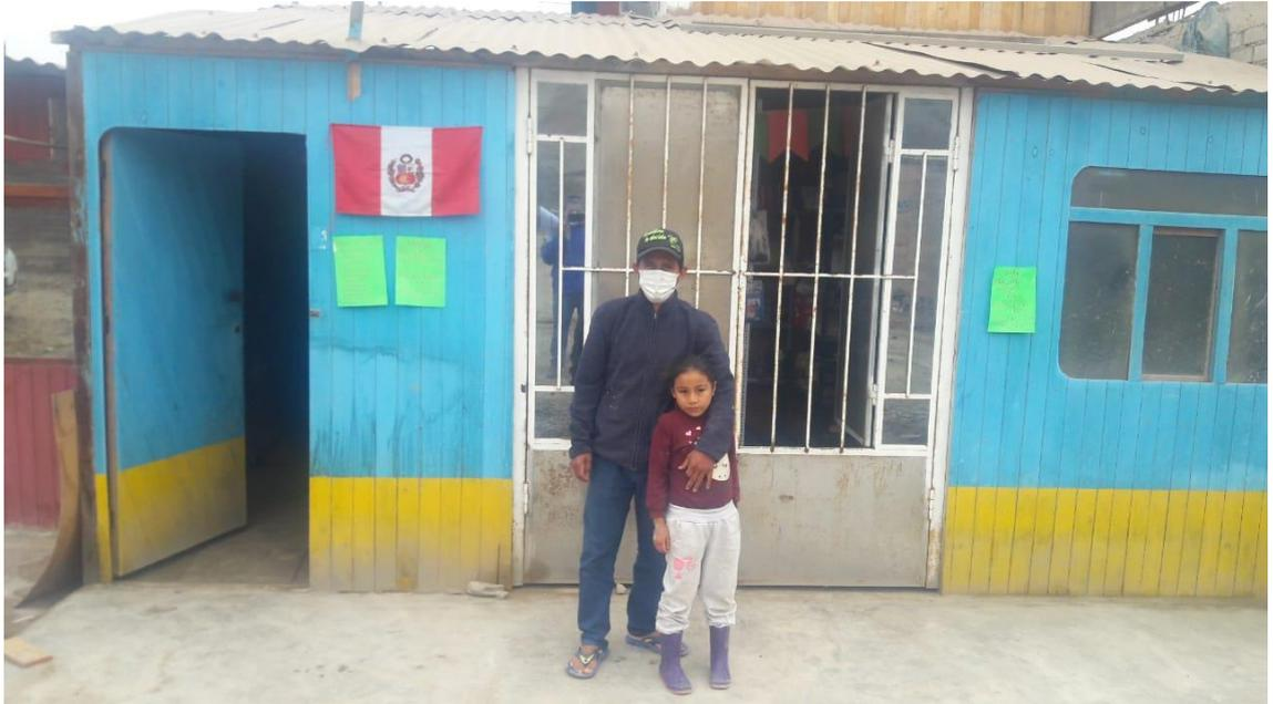
FOTOGRAFÍA N° 3. Mz. N, Lote 28 vivienda con material de madera, cimiento de cemento y estado regular.
