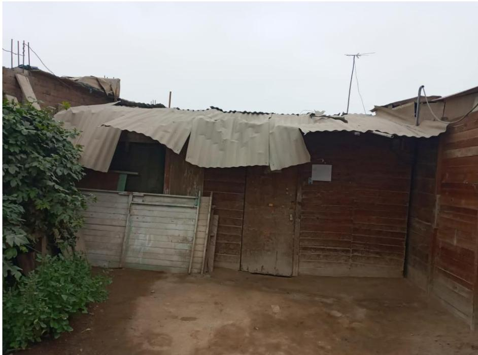
FOTOGRAFÍA N° 8. Mz. T, vivienda de material de madera, no cuenta con cemento y se encuentra en mal estado.
