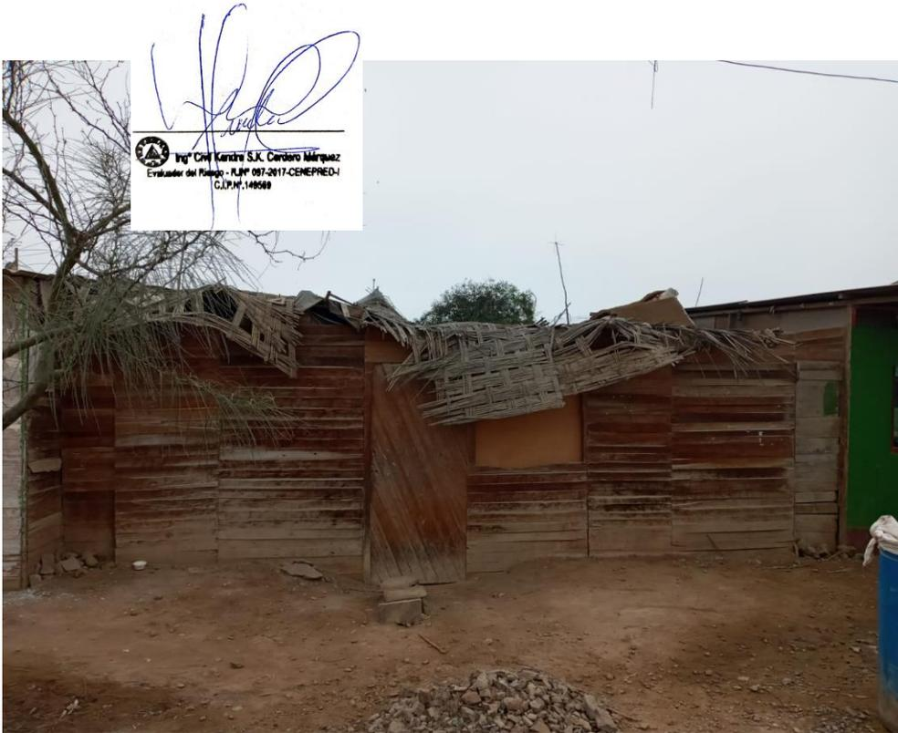
FOTOGRAFÍA N° 9. Mz. T, vivienda de material de madera, no cuenta con cimiento y se encuentra en un mal estado.
