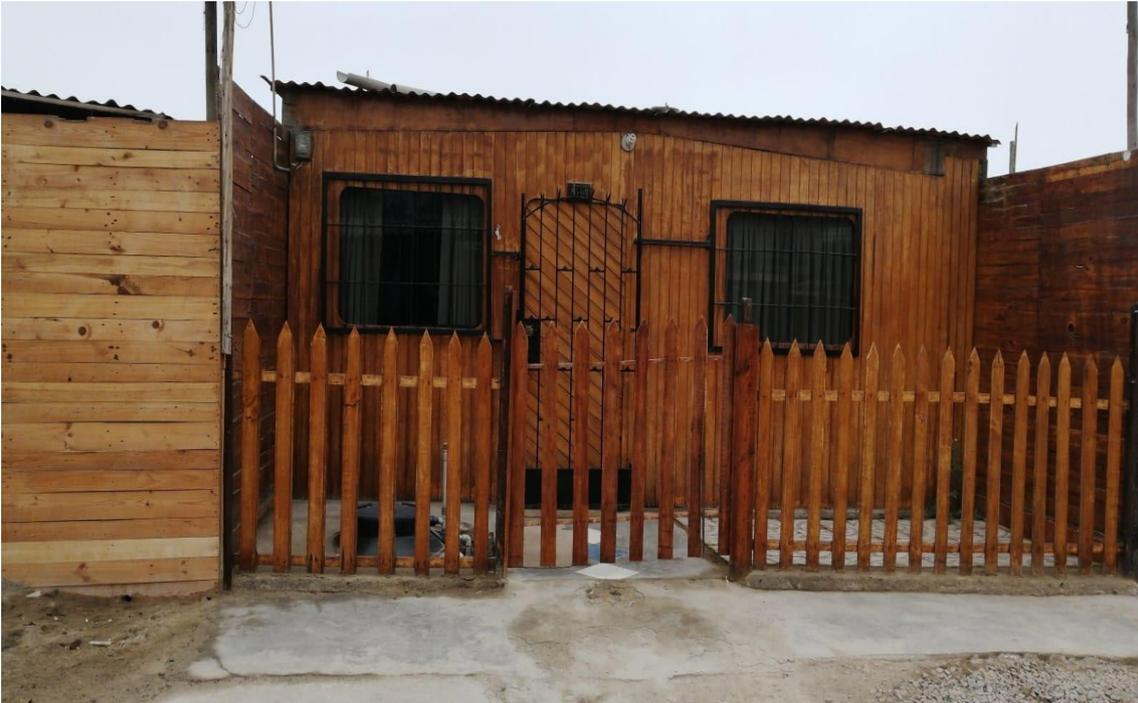
FOTOGRAFÍA N° 12. Mz. U, lote 12 vivienda de material de madera, cimiento de concreto y se encuentra en buen estado.
