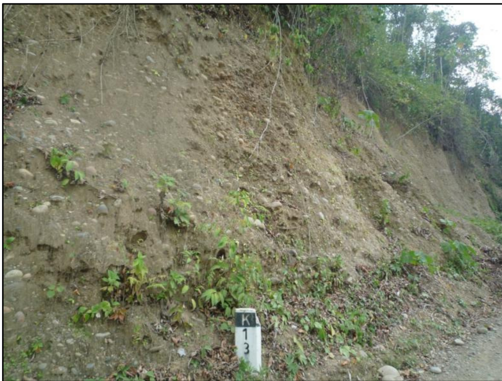
Foto N°6.- Secuencia de conglomerados, en una matriz arenosa. Se aprecia en el talud pequeños depósitos de derrumbes.
