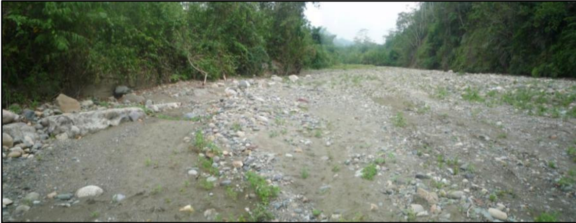
Foto N°8.- Vista aguas arriba del cauce del río Mayapo, se muestra colmatado por gravas y arenas.
