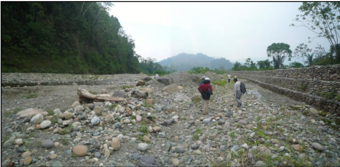
Foto N°10.- Gavión ubicado en la margen derecha del río Mayapo.
