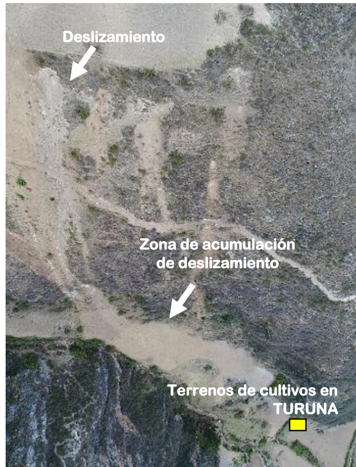
Figura 15. Vista de la zona de acumulación del deslizamiento del 2018. Este material afectó terrenos de cultivo del sector Turuna.
