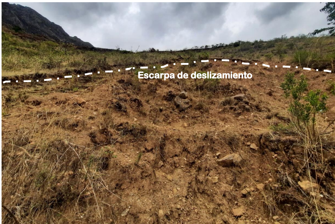
Figura 5. Deslizamientos en depósitos –coluvio-deluviales
