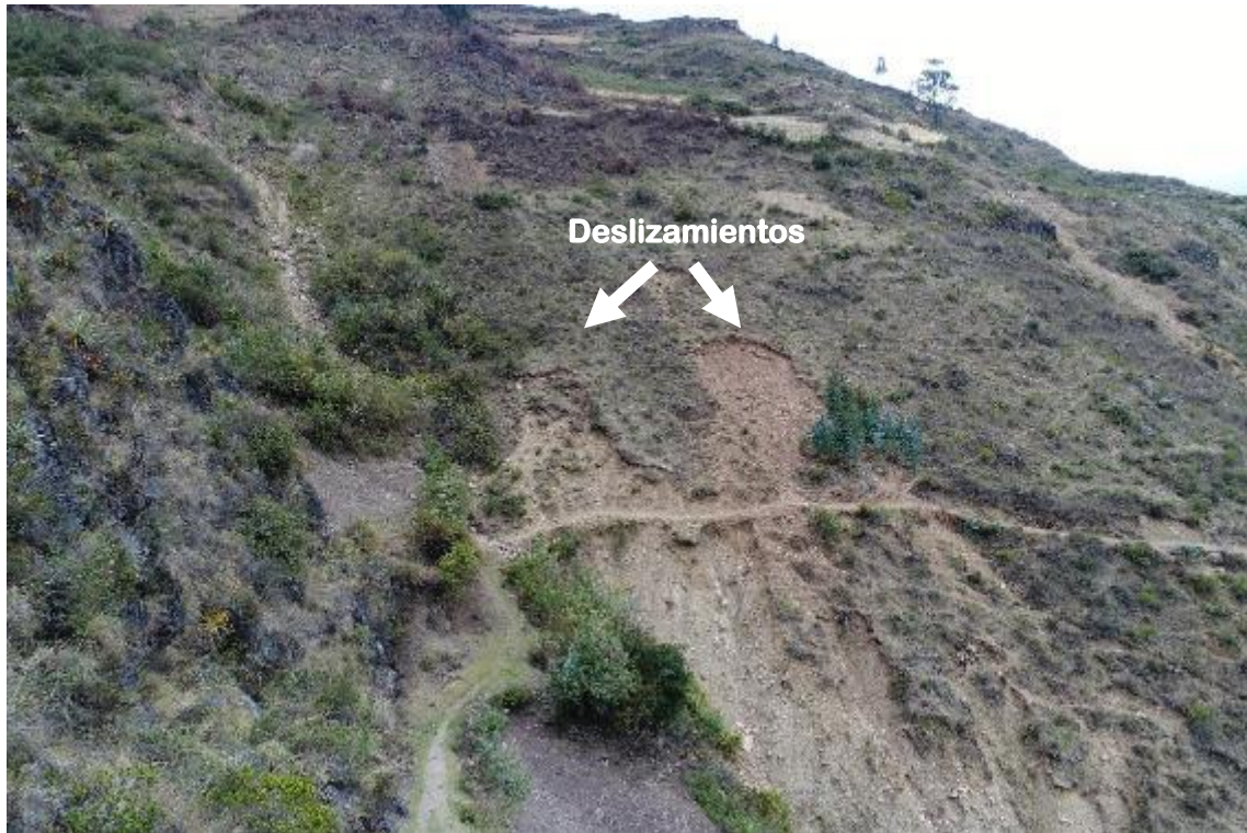
Figura 17. Vista de deslizamientos en el sector 2 del área de estudio.
