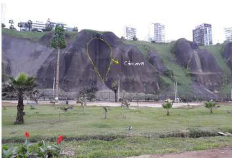
Gráfico N°4: Cárcava en acantilado de la Costa Verde - Miraflores
