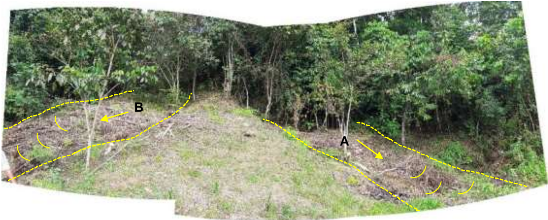
Figura 13. Deslizamientos identificados en el sector 27 de Julio que afectaron áreas de cultivo y la vía de acceso al sector en mención. Los deslizamientos A y B se originaron a consecuencia de las intensas precipitaciones pluviales ocurridas en la zona de estudio. Vista al este
