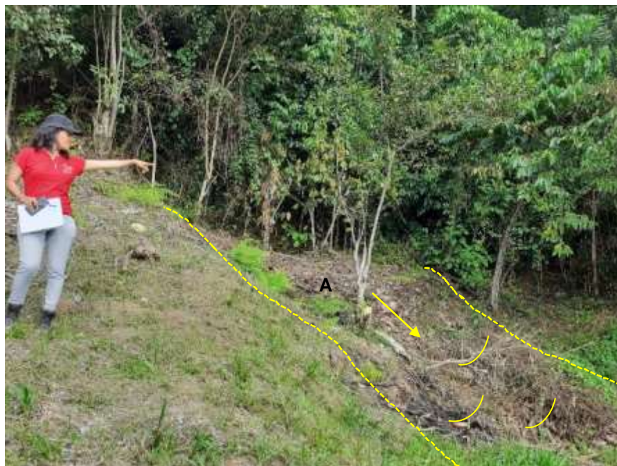
Figura 14. Deslizamiento A identificado en la zona de estudio. La ocurrencia de este deslizamiento afectó la vía de acceso al sector 27 de Julio, así como áreas de cultivo. Vista al sureste
