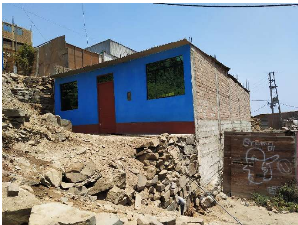
Vista de la vivienda Mz. Y13 Lt. 15, donde se encuentra asentado en pirca y cercana a desnivel.
