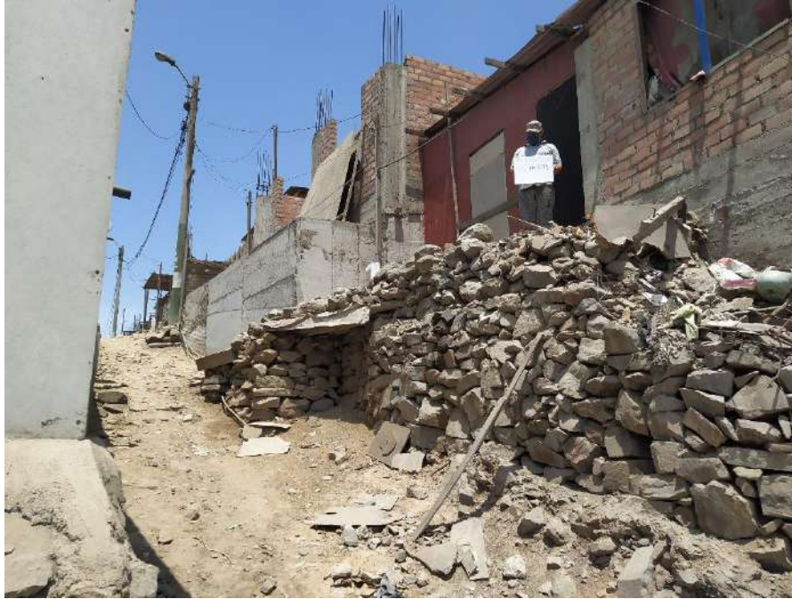
Vista de la Calle Los Lirios donde se aprecia terreno relativamente inclinado y la manzana Y10 del lado derecho.
