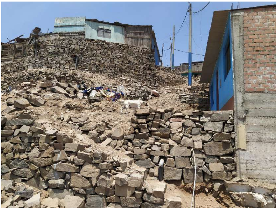
Vista del Pasaje S/N, donde se aprecia gran pendiente y la vivienda Mz. Y13 Lt. 15 del lado derecho.
