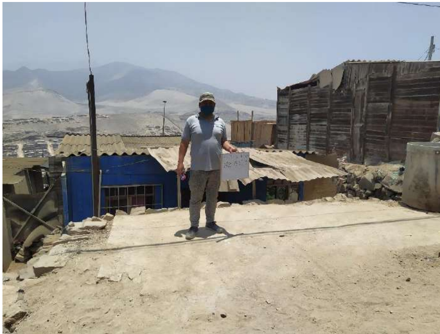
Vista de la vivienda Mz. Y6 Lt. 3, donde se encuentra con un desnivel mayor a 1.80 m respecto al nivel de la calle Los Quinulales.
