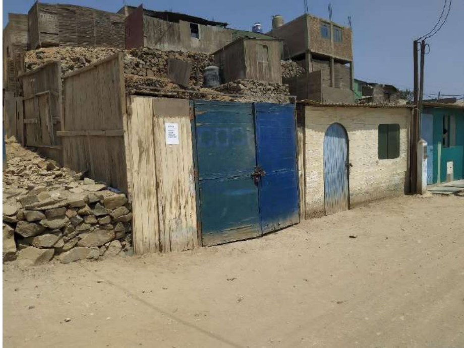
Vista de las viviendas de la Mz. Y12, donde se aprecia desnivel entre las viviendas. Imagen tomada entre las calles 25 de Mayo y Los Conquistadores.
