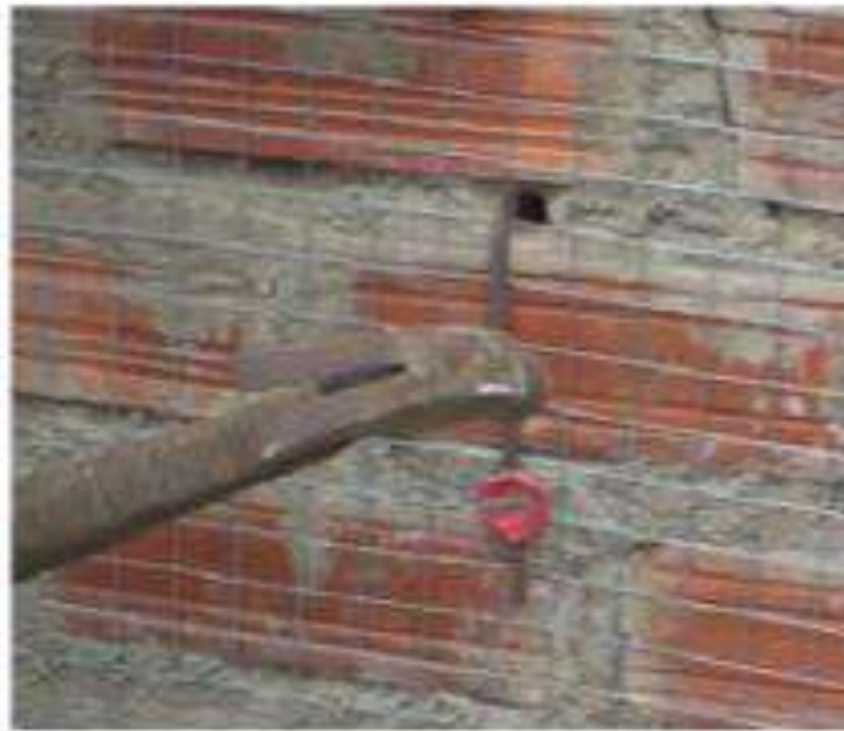
Ilustración 7: Conectores de # 8 dobladas a 90°
