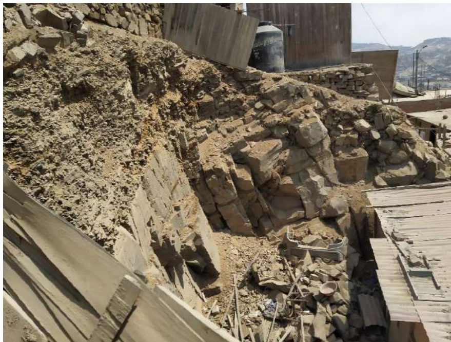
Vista del gran desnivel que presenta la parte posterior de la vivienda de la Mz. Y12 Lt. 7..
