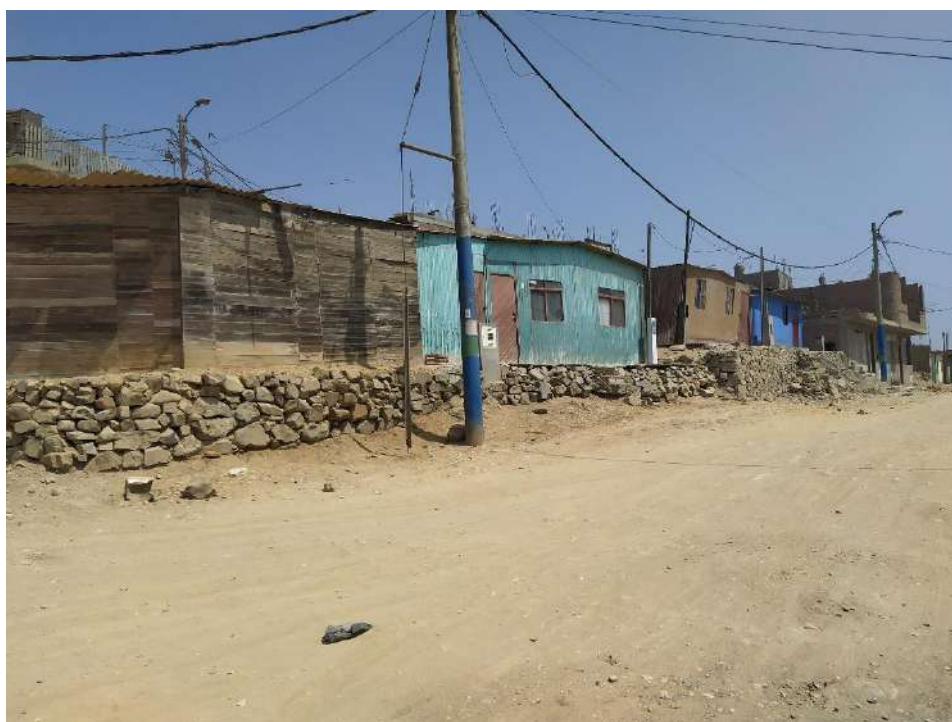
Vista de las viviendas de la Mz. Y11 donde se aprecia que están asentadas en pircas. Imagen tomada desde la Ca. 25 de Mayo.
