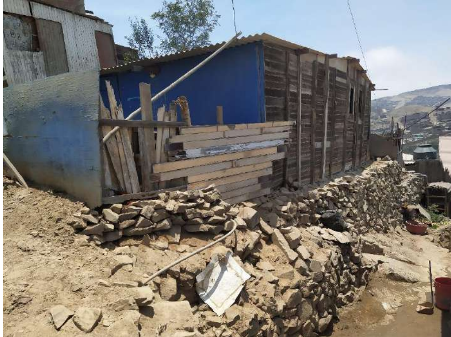
Vista de la vivienda Mz. Y4 Lt. 3, donde se encuentra asentado en pirca y cercana a gran desnivel.
