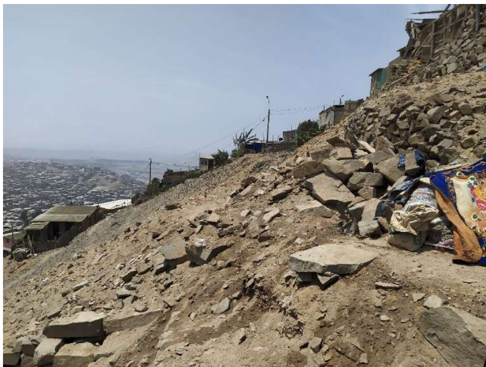
Vista del parque Y13 Lt. 16, donde se aprecia terreno inclinado. Imagen tomada desde la vivienda Mz. Y13 Lt. 15
