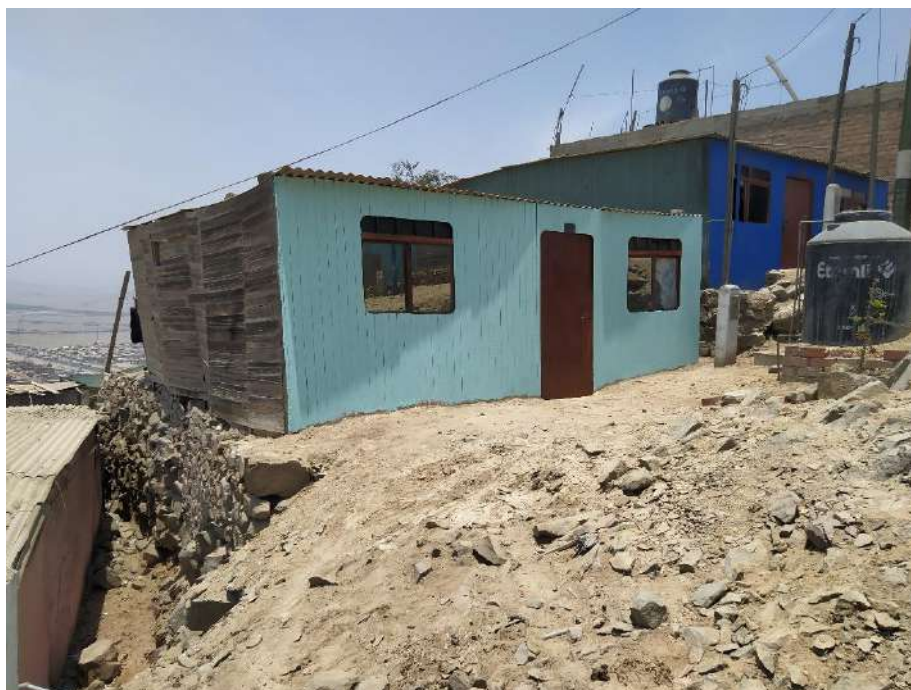
Vista de la vivienda Mz. Y4 Lt. 6, donde se encuentra asentado en pirca y cercana a gran desnivel.
