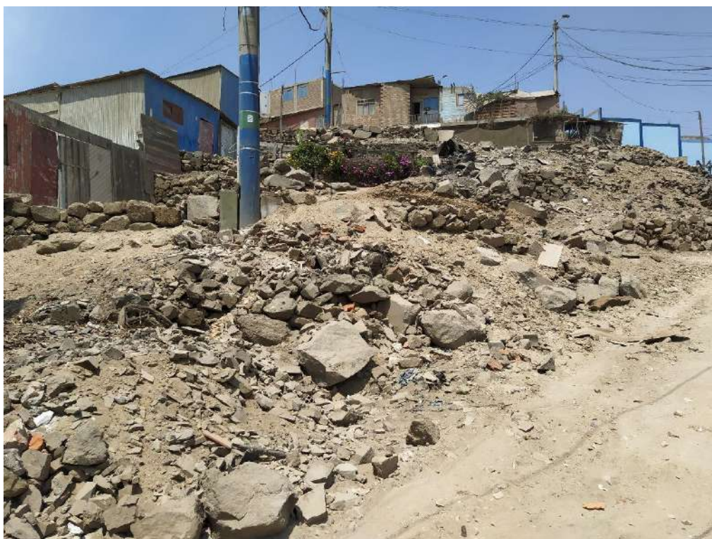
Vista de la Mz. Y13 (izquierda) y Mz. Y12 (parte superior), imagen tomada desde Jr. Santa Rosa.
