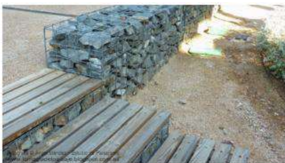
Ilustración 2. Muro de gaviones a implementar.
