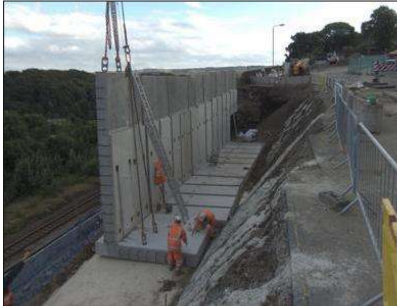
Ilustración 5. Muro de contención de concreto armado
