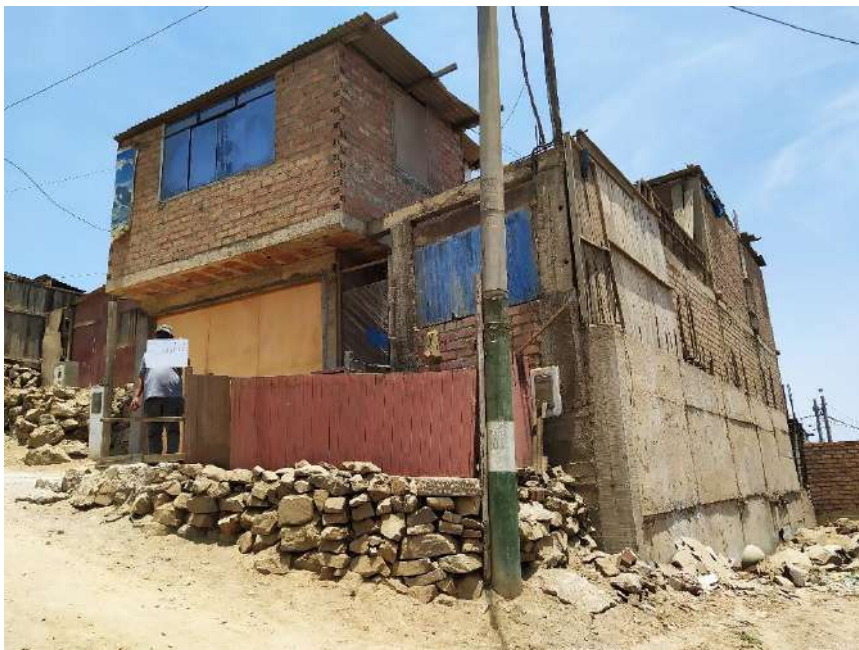
Vista de la Mz. Y8 Lt. 21 y del muro de concreto de la Mz. Y8 Lt 20
