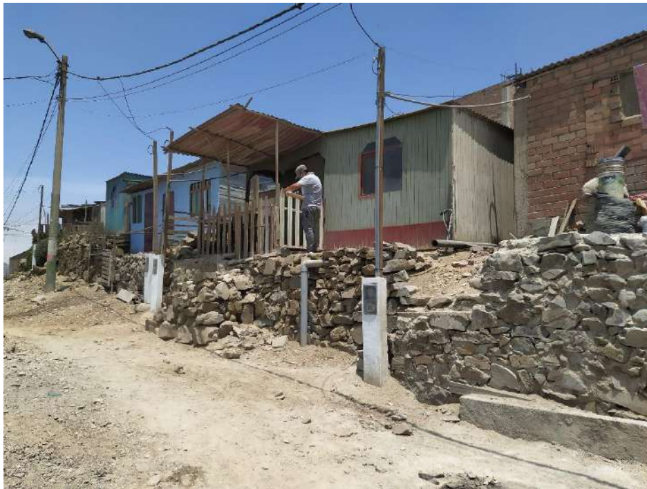
Imagen de las viviendas de la Mz. Y10 asentadas sobre pirca.
