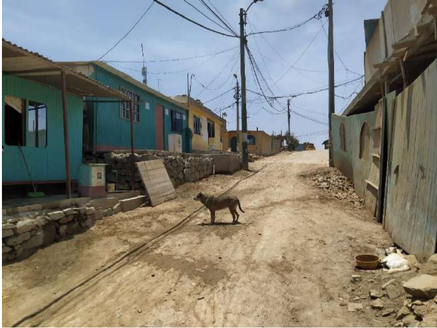
Imagen de la Calle Las Orquídeas, entre las manzanas Y8 (izquierda) y Y11 (derecha). Se puede visualizar que las viviendas de la Mz. Y8 se asientan en pircas.
