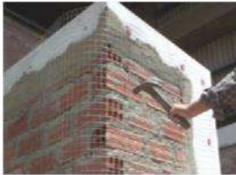
Ilustración 6: Malla electrosoldada en muros de tabiquería.
