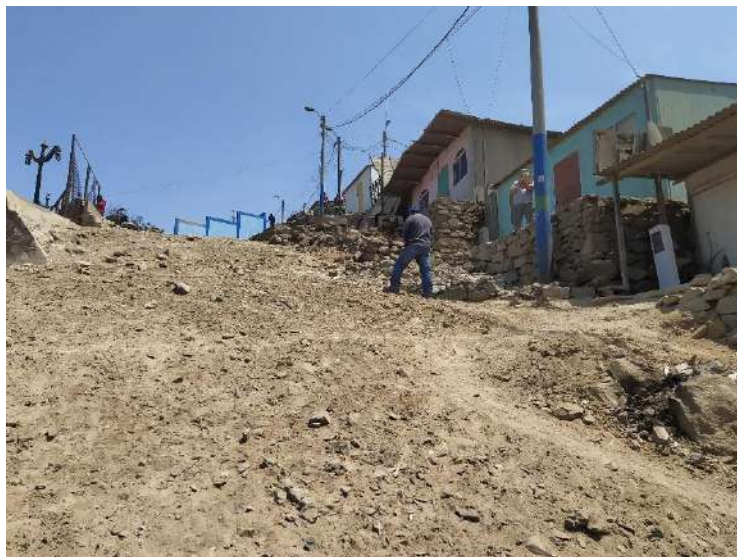
Vista de la Calle S/N donde se aprecia gran pendiente y la manzana Y14 del lado derecho.
