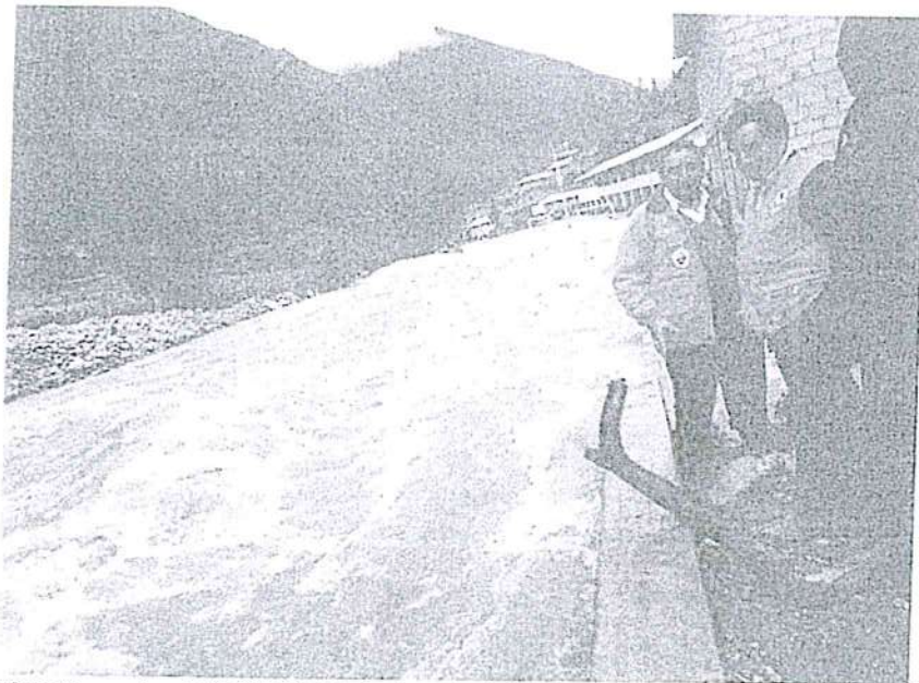
Foto N° 07; Tomada el 06.03.2015, desborde del Río Macho inunda Centro Poblado de Tambos – Ulcumayo
