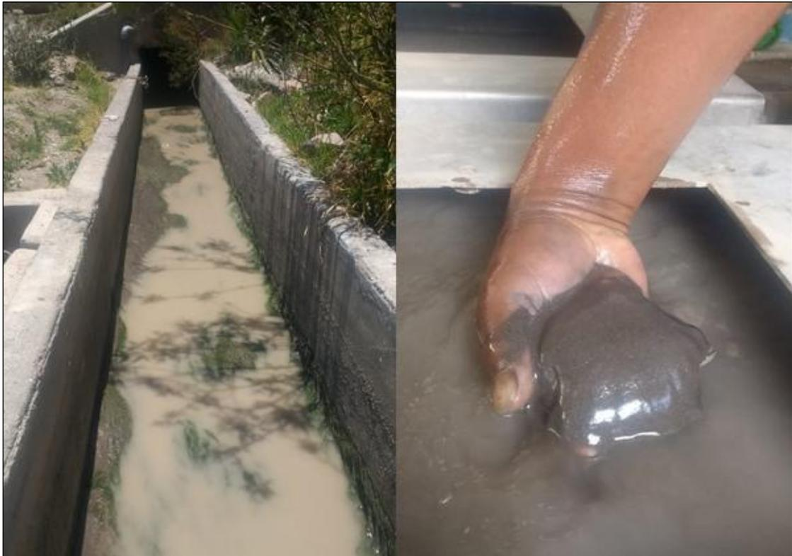
**Figura 27:** Colmatación de los canales de la Planta Hidroeléctrica Lluta y Llucta reportado en el mes de octubre del año 2020.
