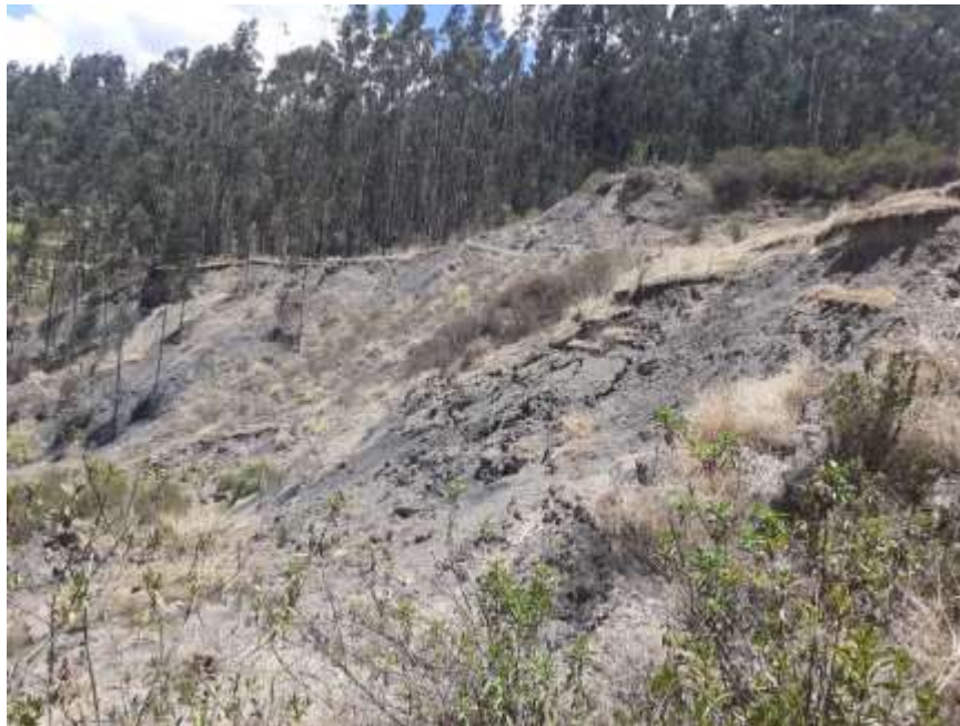
Fotografía 8. Deslizamientos recientes identificados en la parte baja del centro poblado de Cajay.
