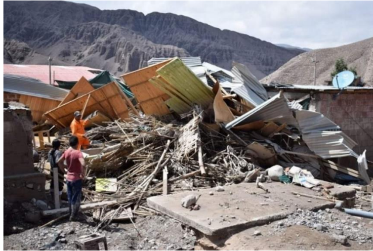
Figura 4: Efectos del huayco del 8 de febrero del 2019.
