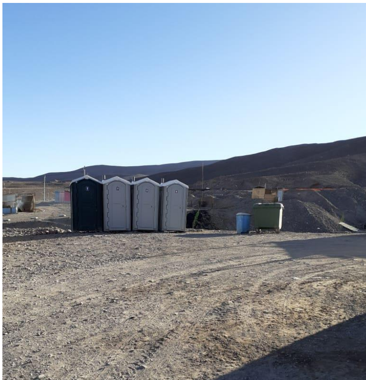
Figura 14: Baños químicos instalados en el albergue de Alto Mirave.
