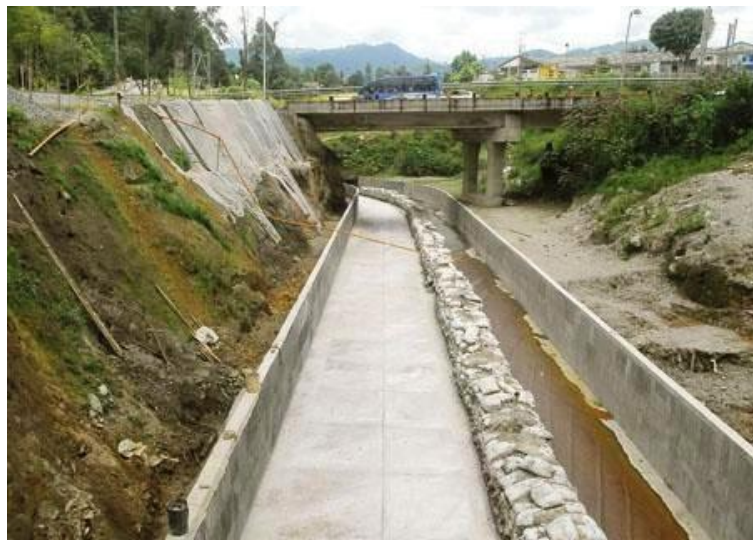
Figura 52: Canalización de un río con concreto armado.
