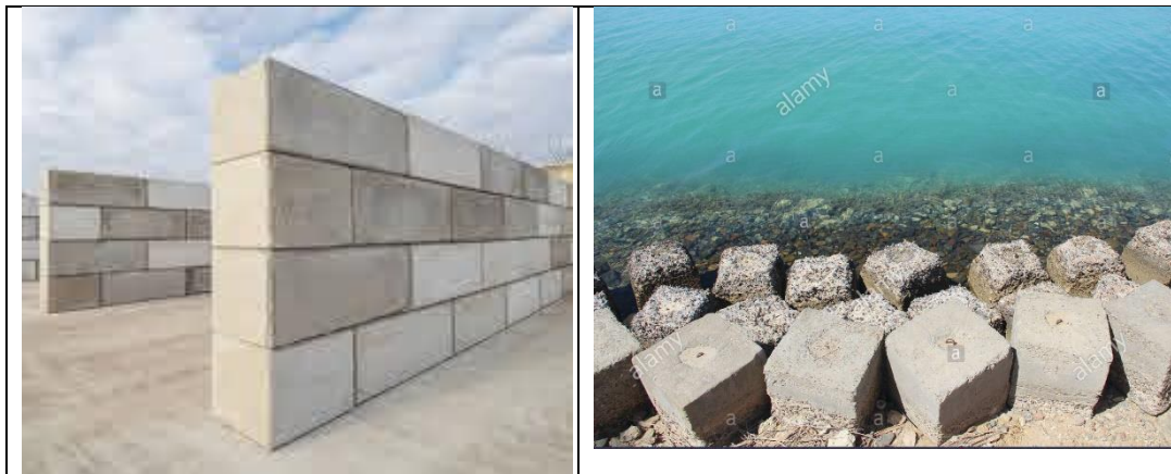
Figura 53: Canalización por medio de bloques de concreto.
