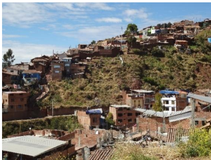
Fotografía 6: Laderas empinadas, margen derecha quebrada camino Real, Fuente: Equipo Técnico SGOT/PM41ZRE
