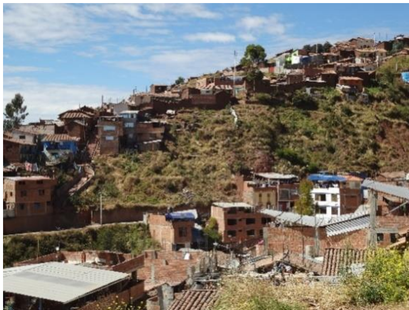
Fotografía 10.- Material de relleno, tomada extremo sur del área ZRECU04-05.
