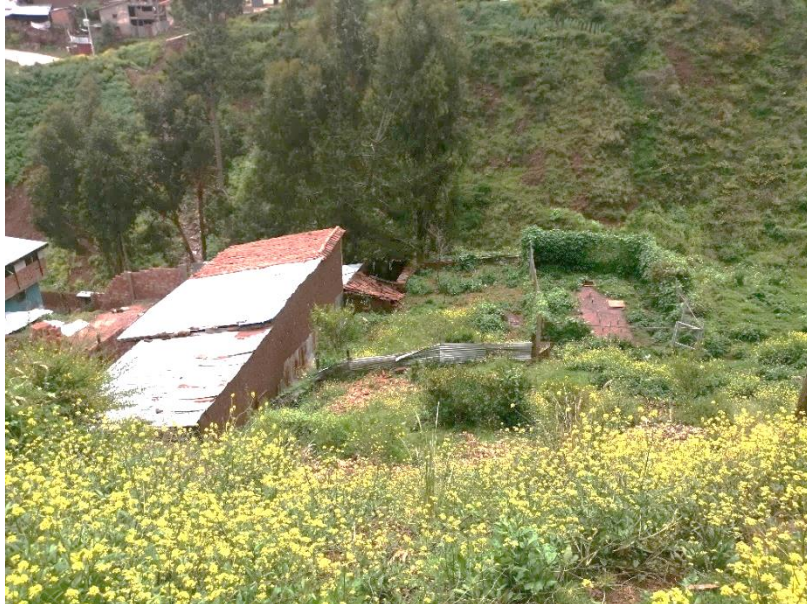
Fotografía 17: Pendiente moderadamente empinado donde se encuentran asentadas dos viviendas y un pozo séptico, lugar de deslizamiento activo.
