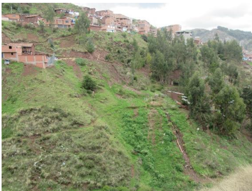
Fotografía 9: Ladera Escarpada, Parte Superior del Deslizamiento.
