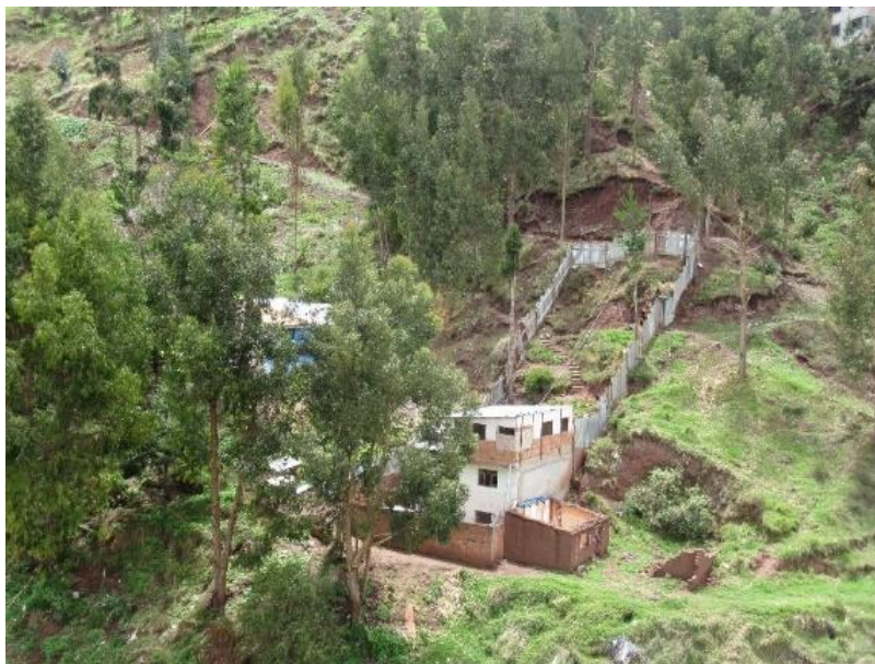
Fotografía 6: Arenisca muy fracturada en la parte baja de la ladera de quebrada Fuente: Equipo Técnico PM 41 ZRE
