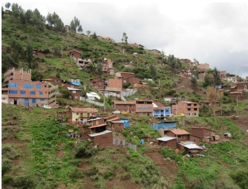
Fotografía 11: Laderas empinadas en zonas de rellenos de cárcavas.
