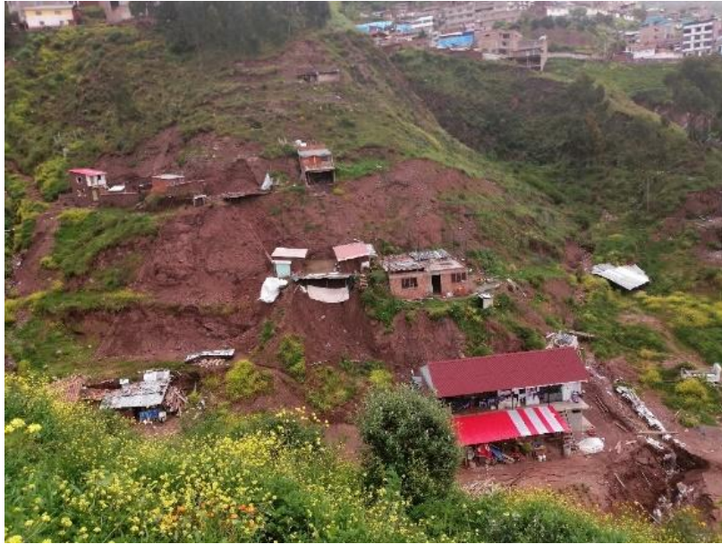
Fotografía 15: Pendiente fuertemente empinado donde se viene edificando viviendas
