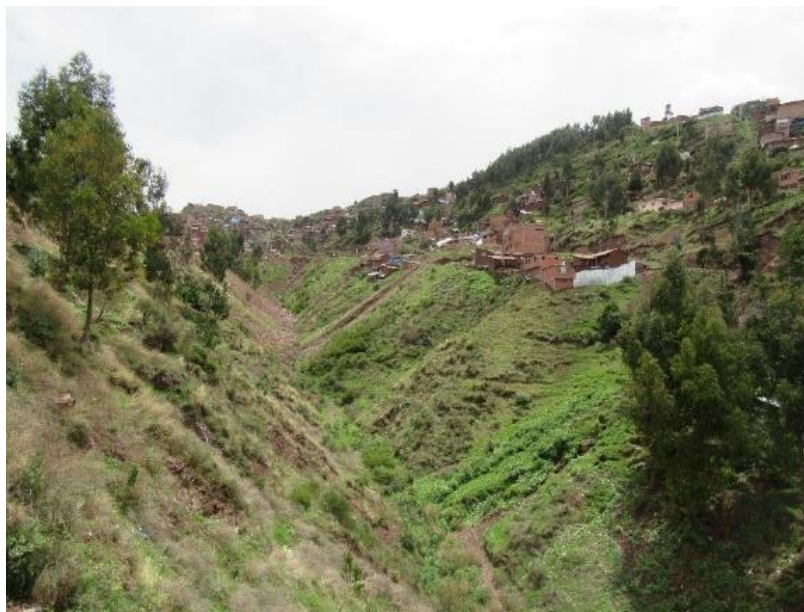
Fotografía 8: Fondo de quebrada donde se depositó el material proluvial
