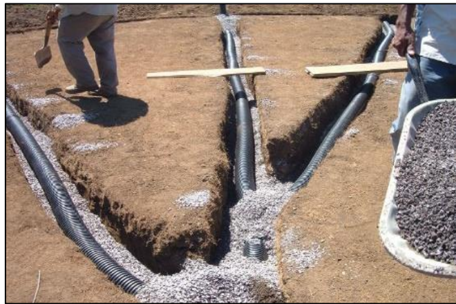
Imagen N° 13 Sistemas de drenaje superficial
