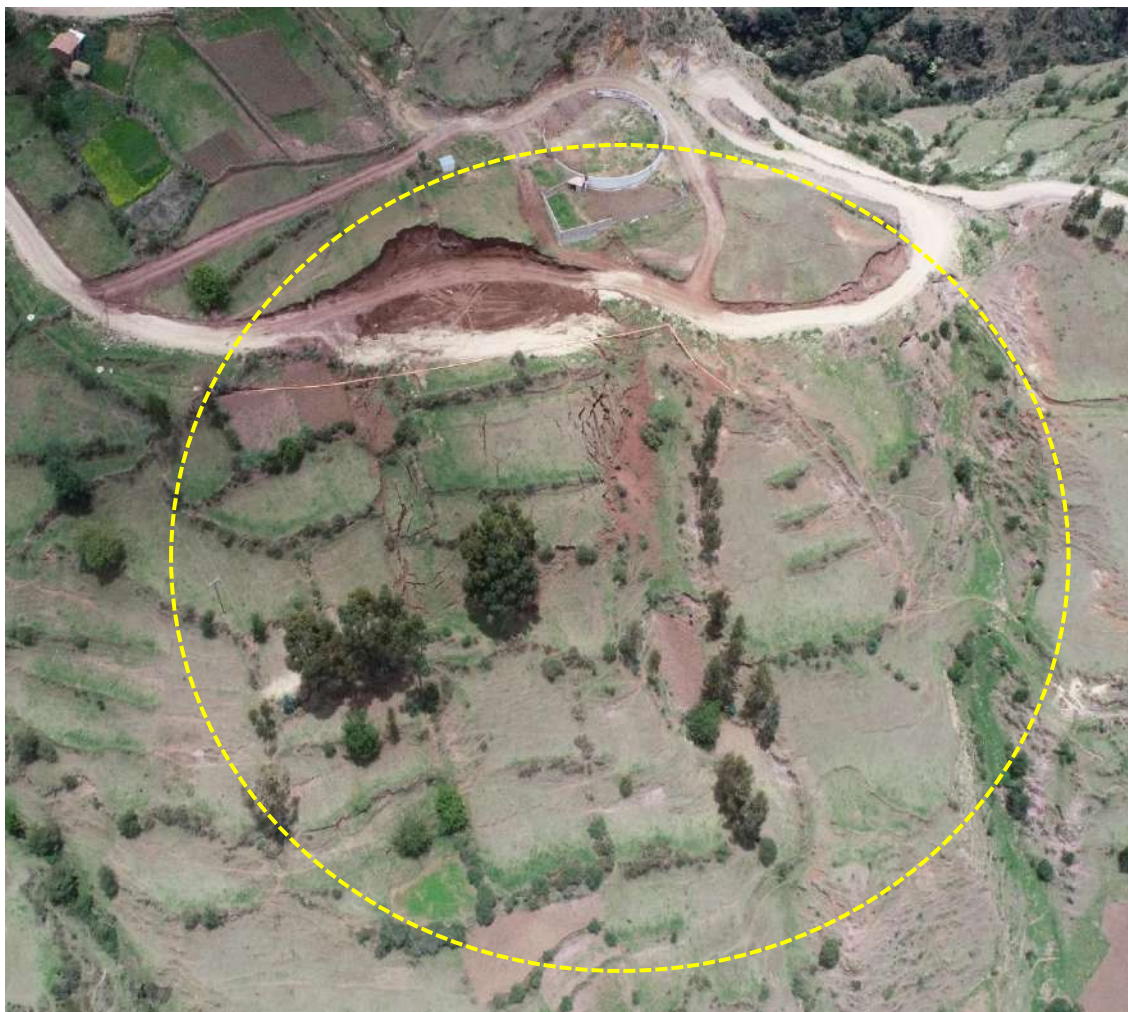
Figura 14. Deslizamiento identificado en el centro poblado de Tiaparo, imagen tomada con el Drone.
