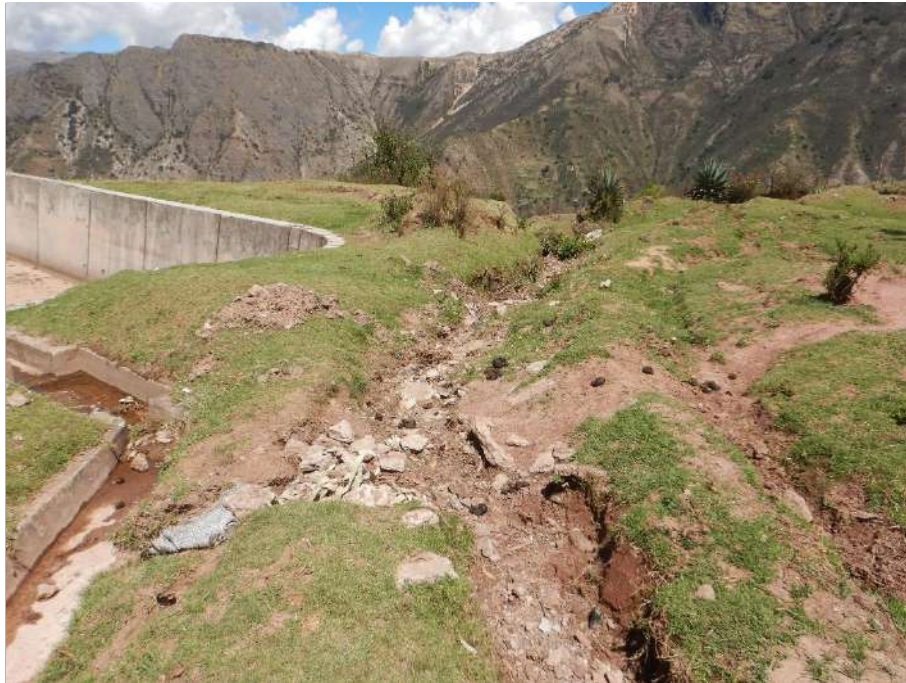
Fotografía 6. Vista donde se observa canal sin revestimiento, la cual discurre directamente al deslizamiento. Actualmente se evidencia, ubicada en las coordenadas UTM 8431564 N, 705360 E, con una altitud de 3621 m s.n.m.
