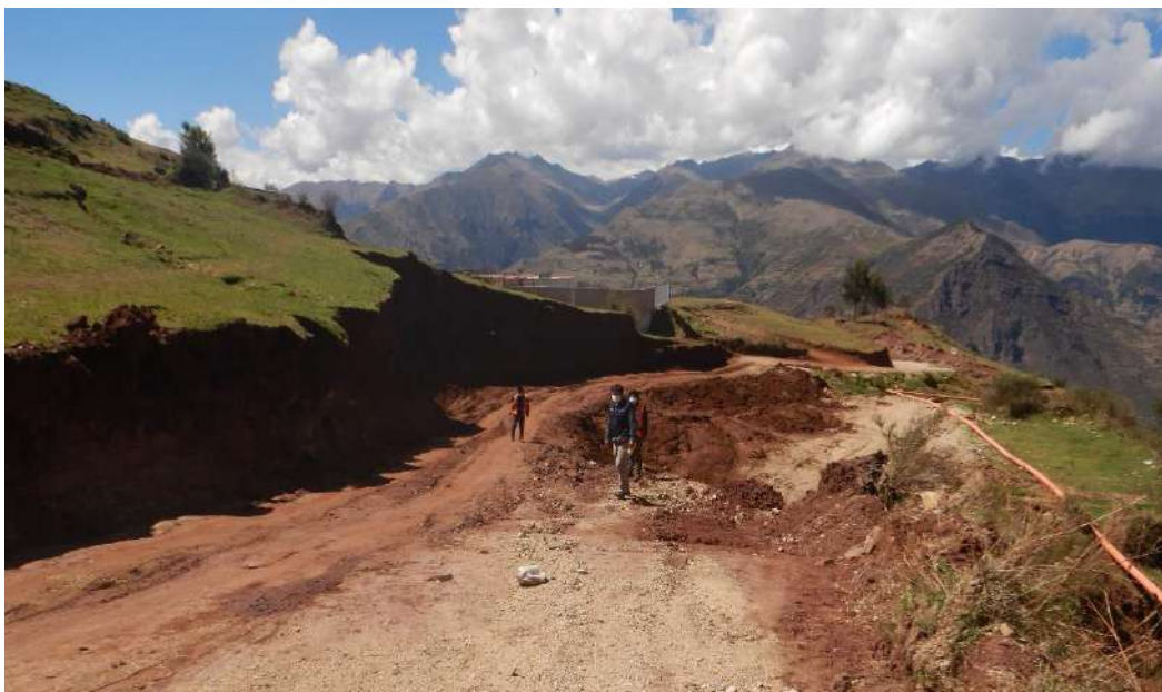
Fotografía 8. Tramo de la carretera afectada por el deslizamiento.
