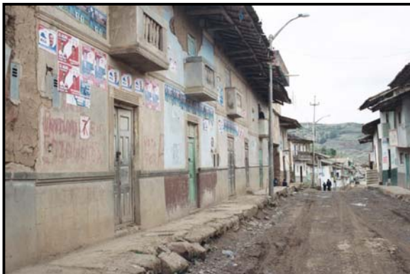
Foto 15.- Vista de la calle 24 de Junio, muestra viviendas están en mal estado.
