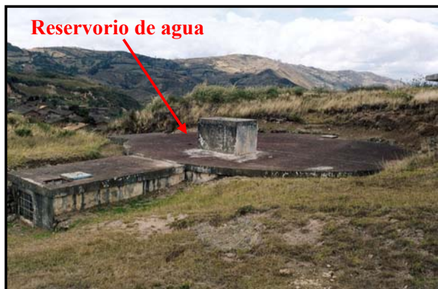
Foto 7.- Reservorio de agua, ubicado en la parte alta del cerro Aparic
