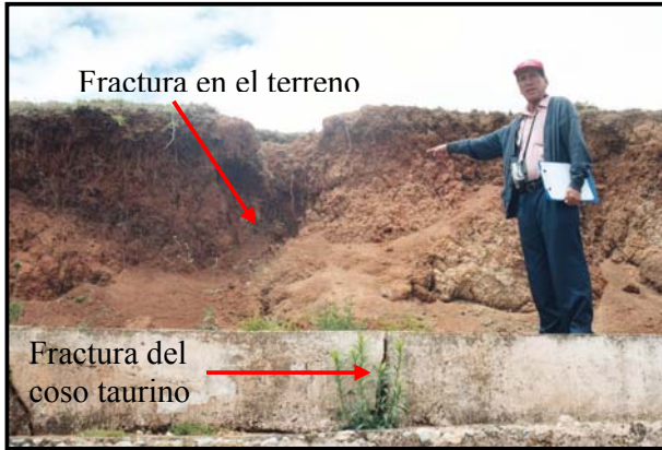
Foto 8.- Fractura ubicada en el coso taurino y el terreno.
