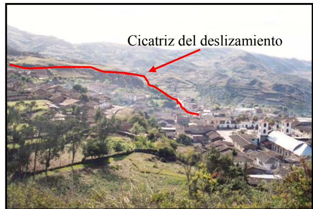
Foto 6.- Parte de la escarpa del deslizamiento antiguo.
