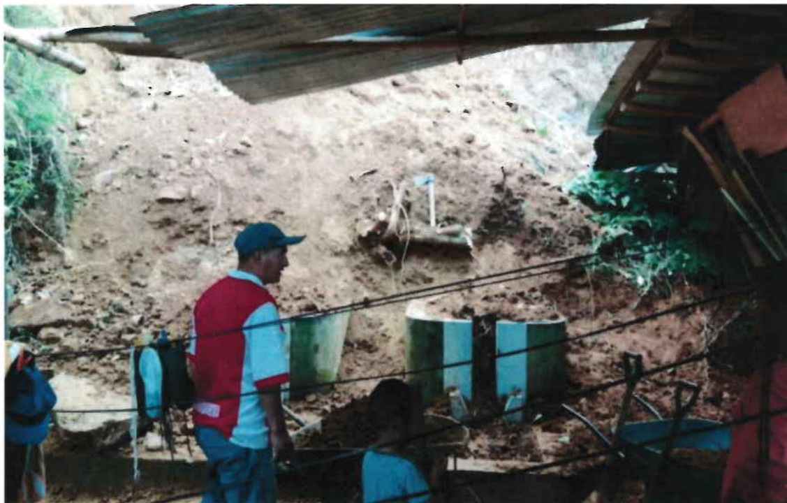
Fotografía 14. Desagües vertidos al ambiente sin tratar debido al mal funcionamiento de las redes de alcantarillado en la ciudad de San Ignacio.
