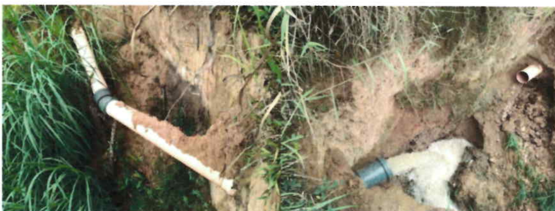
Fotografía 17. Línea de conducción de agua potable afectadas por las lluvias intensas.
