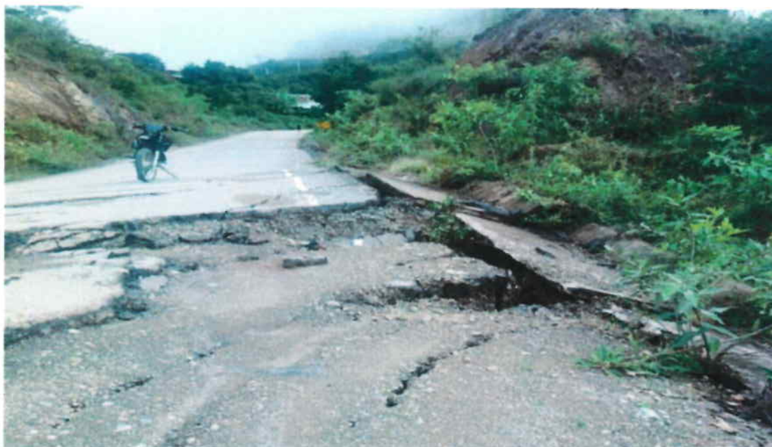
Fotografía 6. Vía afectada por lluvias intensas 119672 10/02/2020.
