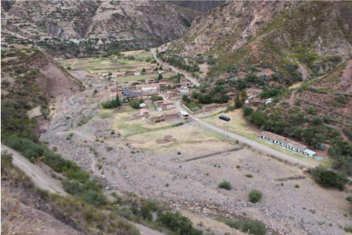
Foto 6: Localidad de Cusibamba Bajo, obsérvese los daños ocasionados por flujos de detritos y erosión causados por lluvias excepcionales. También flujos de detritos pueden ser ocasionados por los derrumbes y deslizamientos que se pueden producir quebrada arriba. Frente a Misca (al NE) se observa un deslizamiento activo que puede dañar Cusibamba Bajo
