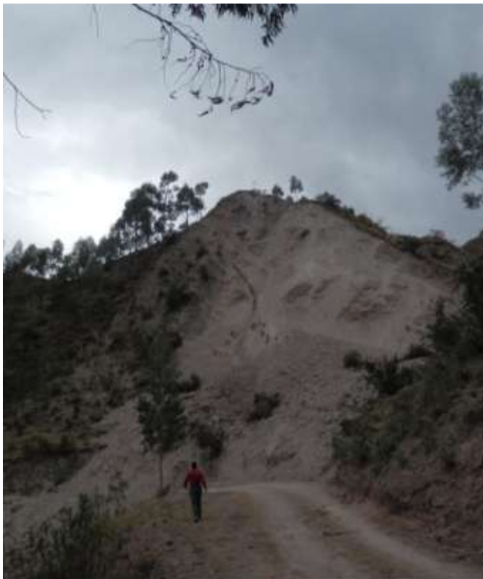
Foto 4: Caída de derrubios en el tramo de la carretera Paruro - Miskas
