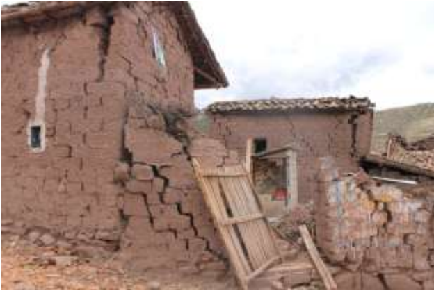
Viviendas destruidas en Misca, obsérvese el tamaño de los mismos (dos pisos) y su diseño estructural (sin refuerzos)
