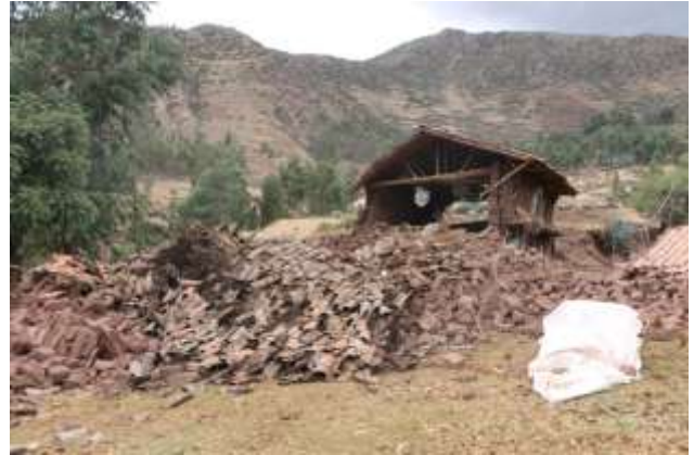
Viviendas destruidas en Misca, obsérvese el tamaño de los mismos (dos pisos) y su diseño estructural (sin refuerzos)
