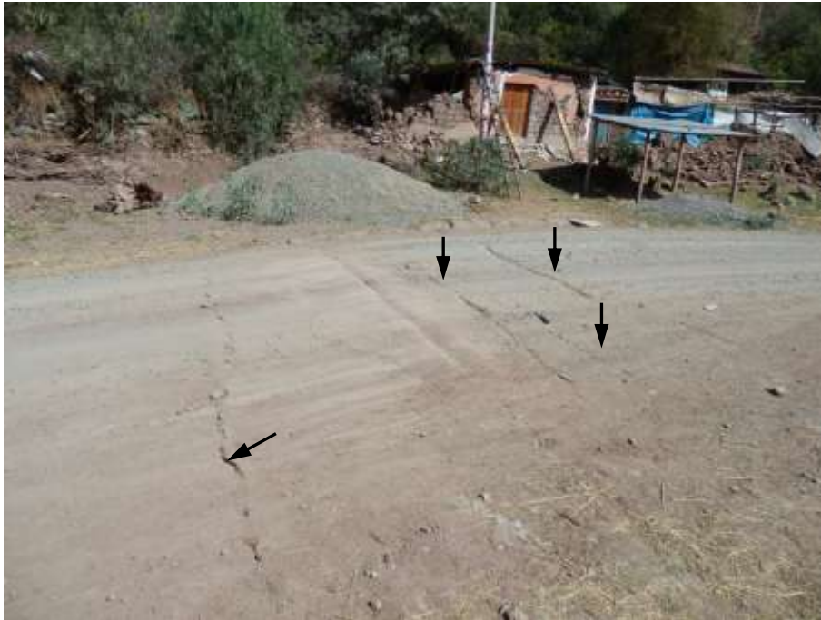
Foto 9: Grieta en el poblado Cusibamba Bajo, tiene una longitud de 25m y afecta la carretera, la dirección principal es N112° y su abertura máxima con 10cm, se observa como las grietas estas en dirección de una vivienda destruida
