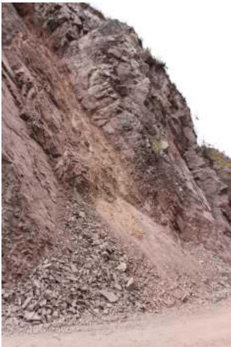
Foto 2: Deslizamientos traslacionales en areniscas. Tramo Misca – Cusibamba, margen izquierda del río Paruro.
