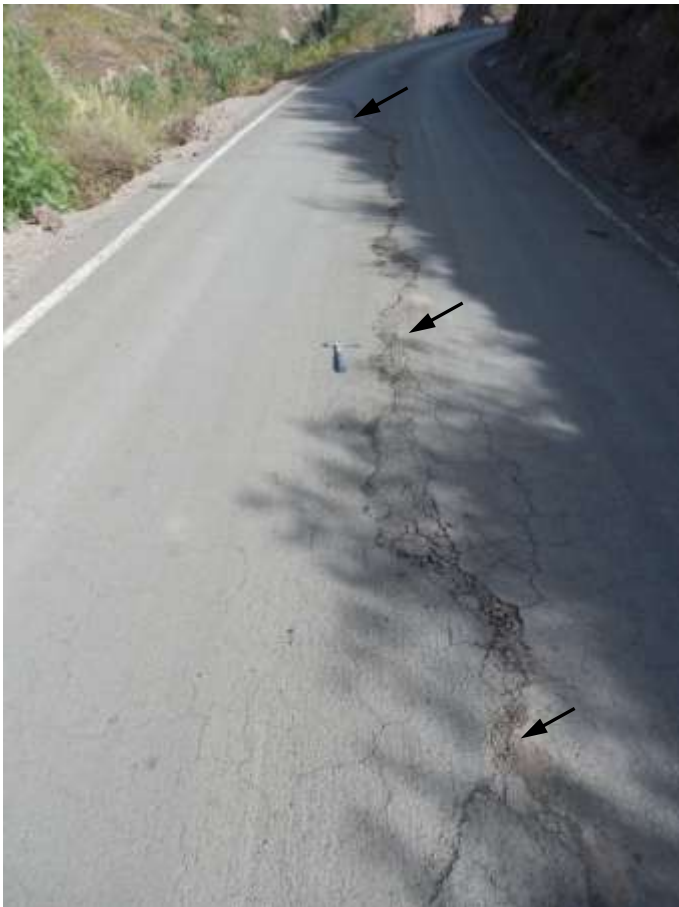
Foto 7: Grieta en el poblado de Miskas, tiene una longitud de 15m con dirección preferente N110°, la abertura máxima es de 7 cm, se observa un tipo de movimiento sinistral.
