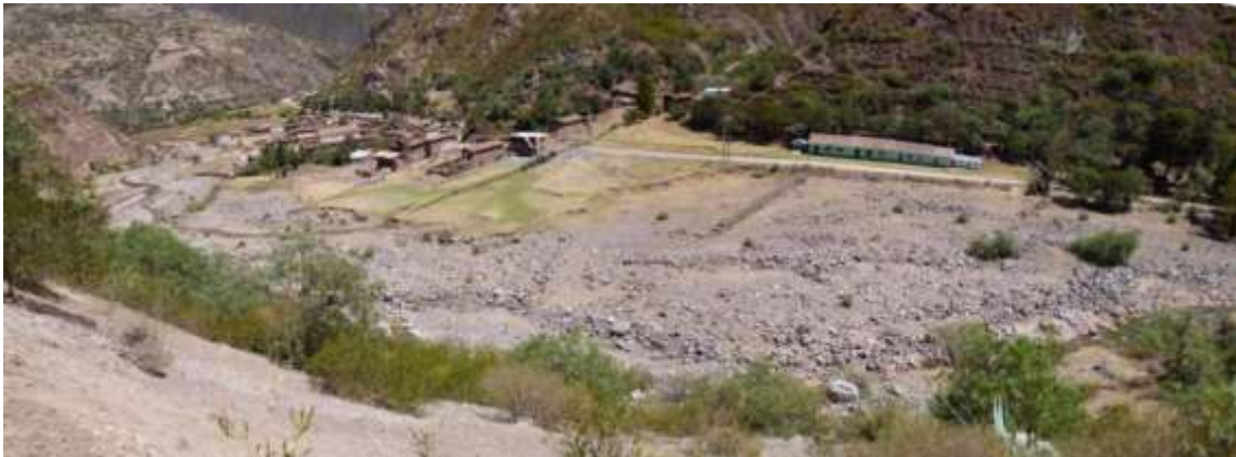
Foto 5: Valle del río Paruro y del poblado de Cusibamba bajo asentado en su margen izquierda cerca a la desembocadura en el río Apurímac, afectado por procesos de erosión fluvial y huaycos, se han colocado espigones con gaviones para evitar que el poblado se afectado.
