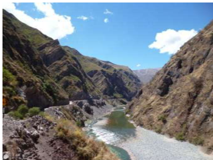
Foto 3: Carretera Cusibamba Bajo-Huaro Bamba trazado en la margen izquierda del valle del río Apurímac, en una ladera que supera los 40° de inclinación.
