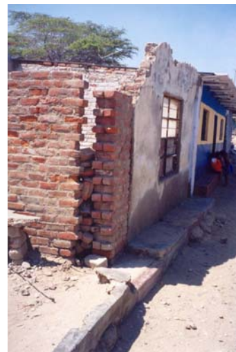
Mala aplicación del Sistema Constructivo. Nótese la falta de confinamiento de los muros.
