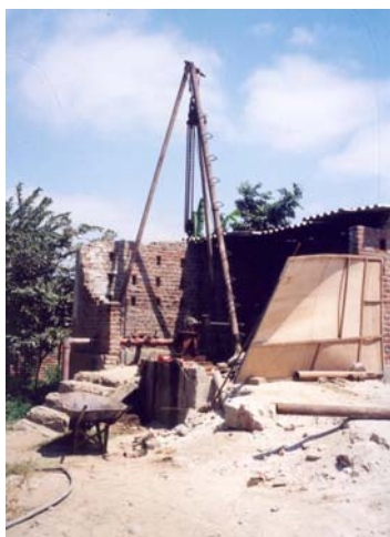
Vista del Pozo tubular de Simbalá 15 L/s.
