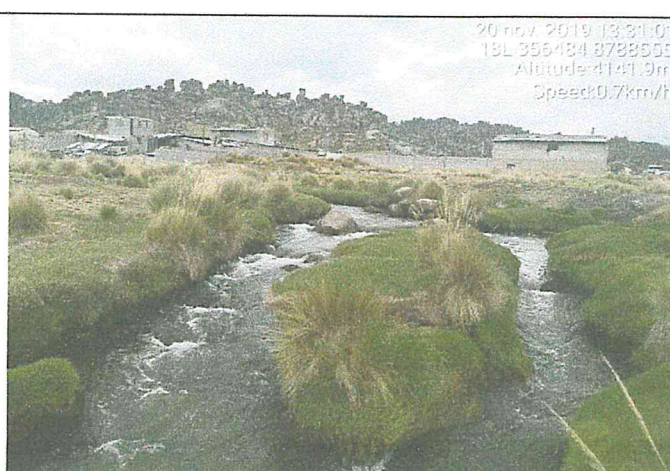
Fotografía 2: Colmatacion del río Anticona en el sector Canchacucho.
