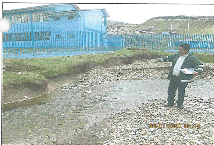
Fotografía 3: Erosion de la margen derecha del río Pucara, buzón de desagüe de la población de los Andes de Pucara expuesta al peligro.
