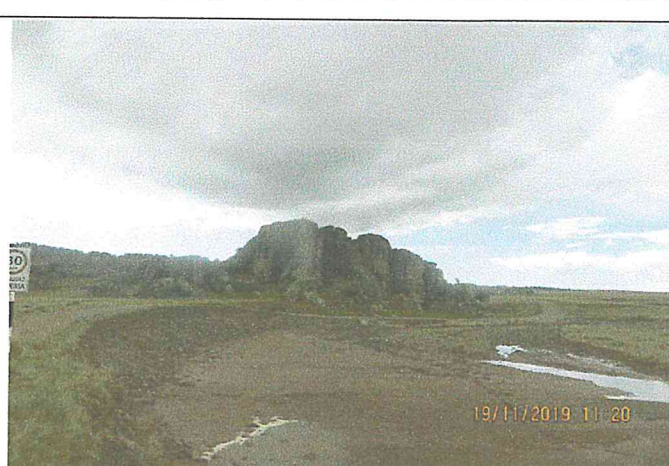
Fotografía 4: Erosión del talud carretera afirmada hacia Rumichaca, margen derecha del río Colorado en el sector Canchacucho
