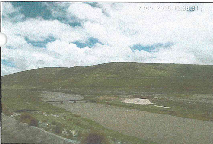
Fotografía 3: Erosion de la margen derecha del rio San Juan, afectacion pase peatonal a la poblacion de Huaraucaca.
