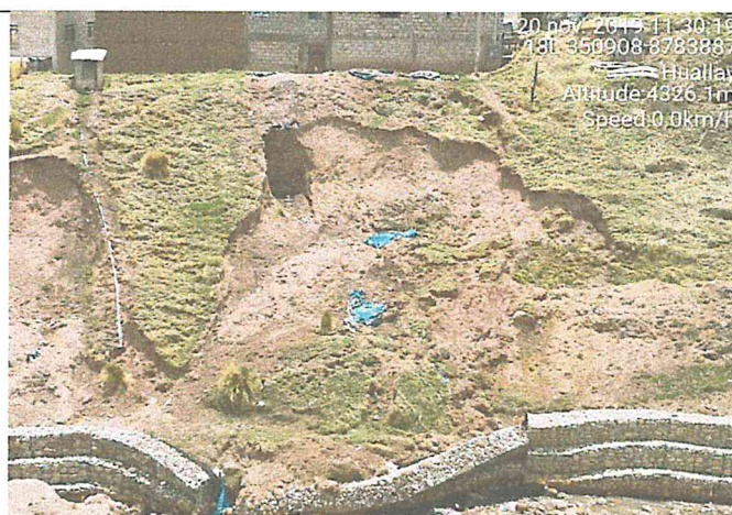
Fotografía 2: Deslizamiento del talud, de los muros tipo gavion en el río San Jose en el sector Huayllay.
