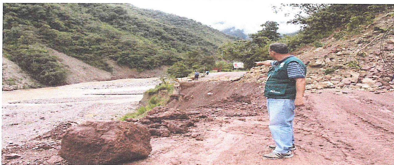
En temporadas de lluvia las quebradas se activan donde se acumulan sedimentos y palizadas causando desbordes afectando a la via nacional
