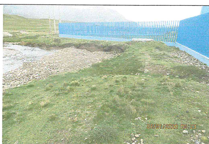
Fotografía 4: Colmatación, deslizamiento del talud margen derecha del río Pucara, podría afectar las infraestructuras de la I.E. Luis Marcelo Callupe.
