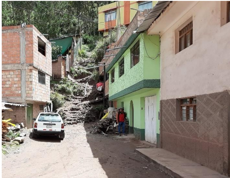
Fotografía 15: Pendientes empinadas con rangos de 14°-27° Fuente: Equipo Técnico PM 41 ZRE
