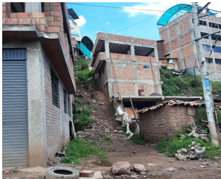
Fotografía 11: ladera empinada Fuente: Equipo Técnico PM 41 ZRE
