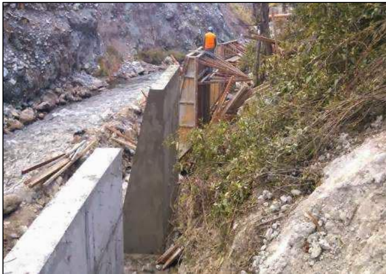
Imagen N° 15 Encauzamiento con muro de concreto ciclópeo
