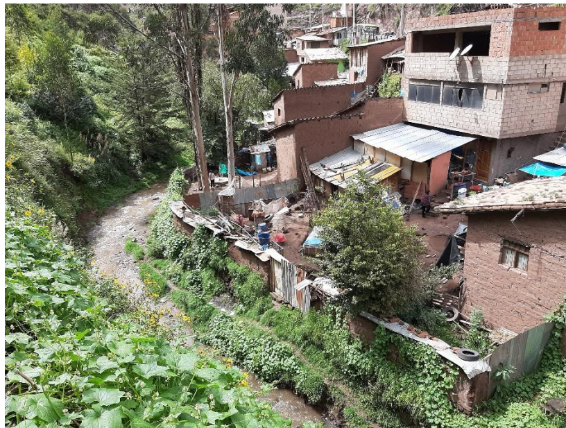
Fotografía 19.- Material de relleno, tomada extremo sur del área ZRESA10-11.
