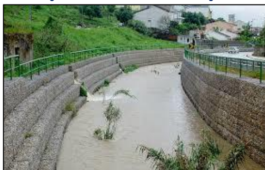
Imagen N° 14 Muro de sostenimiento de gavión.
