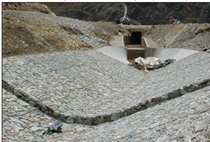
Imagen N° 16 Canalización con gavión (colchón reno)
