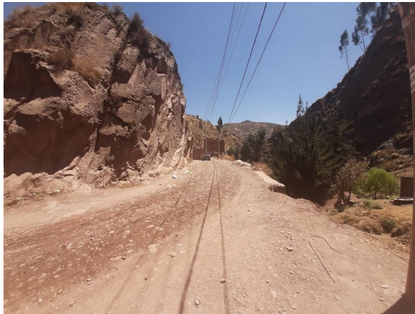
Fotografía 13: Pendientes escarpadas a fuertemente empinadas mayores a 37^\circ formadas en la ladera izquierda del área de estudios Fuente: Equipo Técnico PM 41 ZRE
