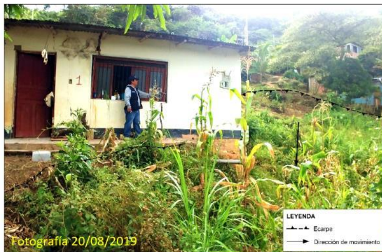
Figura 15: Deslizamiento rotacional en el sector Las Palmeras.
