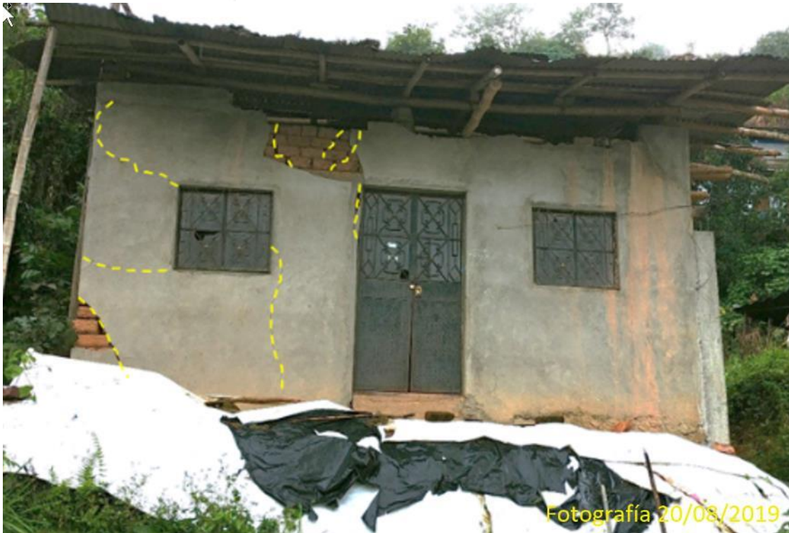
Figura 20: Vivienda con numerosas grietas transversales y longitudinales, al borde del colapso.
