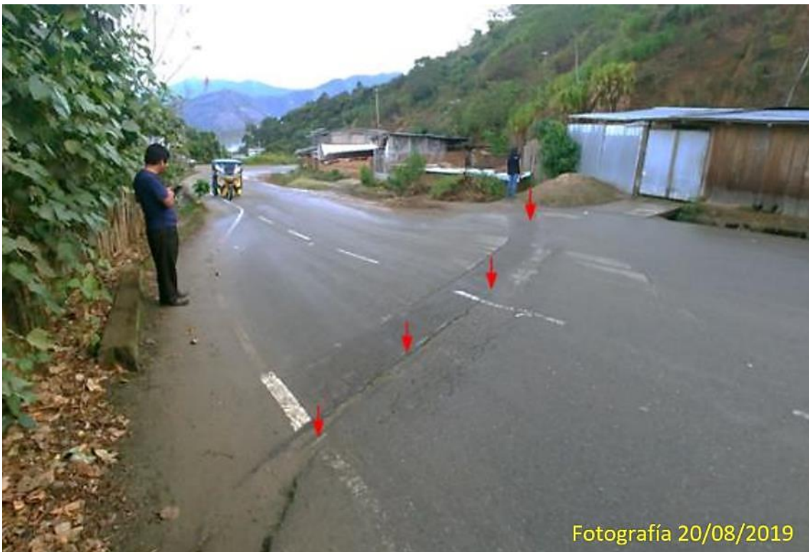
Figura 21: Grieta semicircular que atraviesa la plataforma de la carretera San Ignacio – Namballe.
