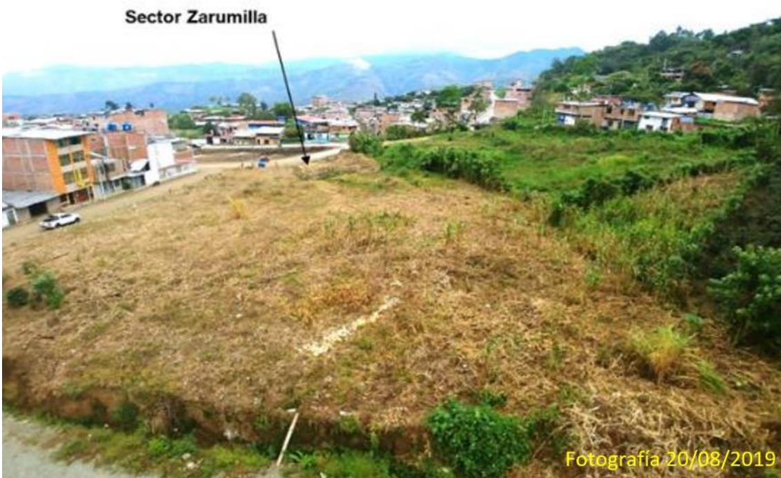
Figura 9: Atenuación de la pendiente en el Sector Zarumilla, que favorece la surgencia de agua subterránea.
