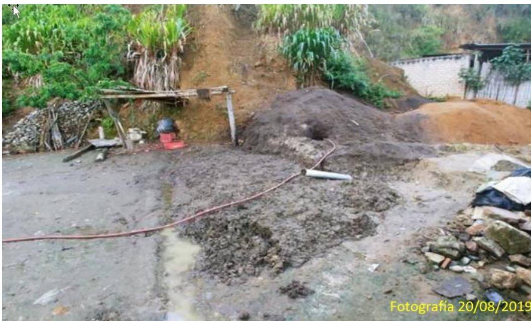
Fotografía 23: Zona destinada a la construcción de ladrillo, nótese que el terreno se encuentra saturado.
