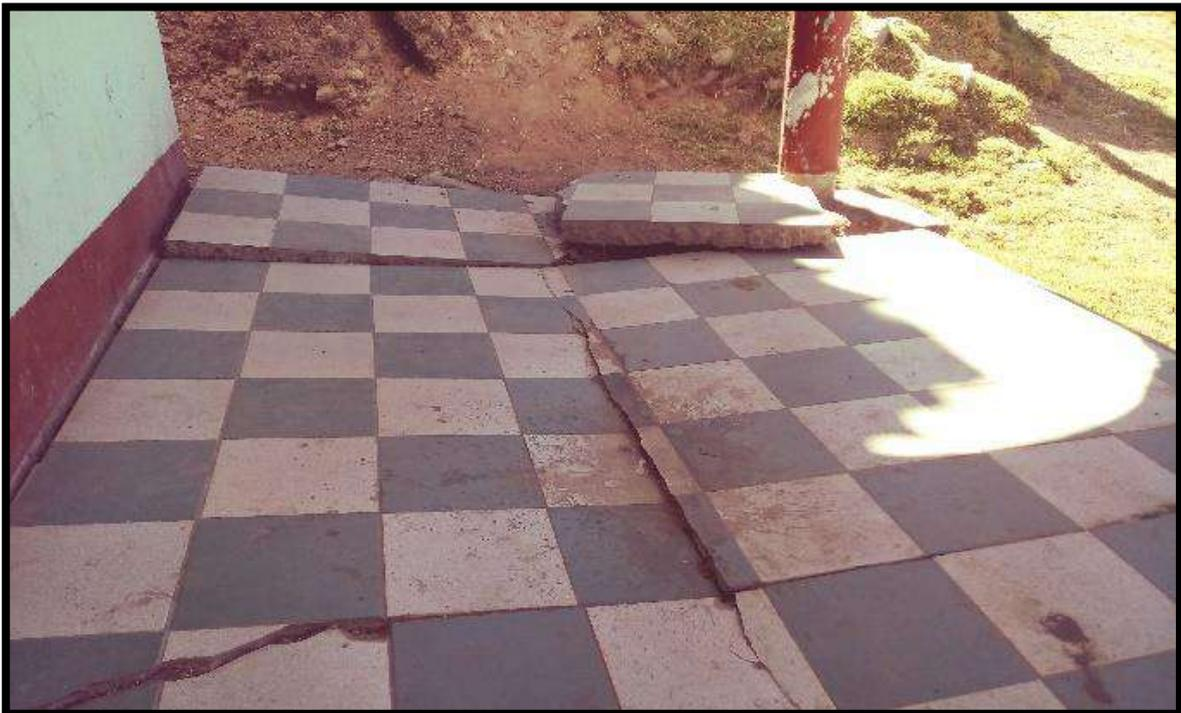
**Imagen N° 14:** Evidencia el Hundimiento y deformación del suelo por efecto de la licuefacción y saturación del suelo que sufrió el local de la Municipalidad Distrital de Chincho.
