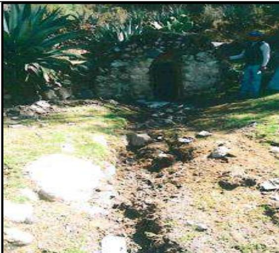
**Imagen N° 5:** Fuente de agua no recubierta ni canalizada adecuadamente presentando con flujo constantemente.
