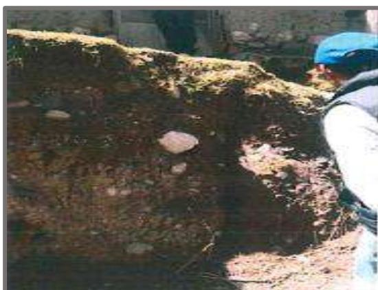
**Imagen N° 4:** Zona urbana de Chincho, en un corte de talud, donde se muestra la heterogeneidad del suelo.
