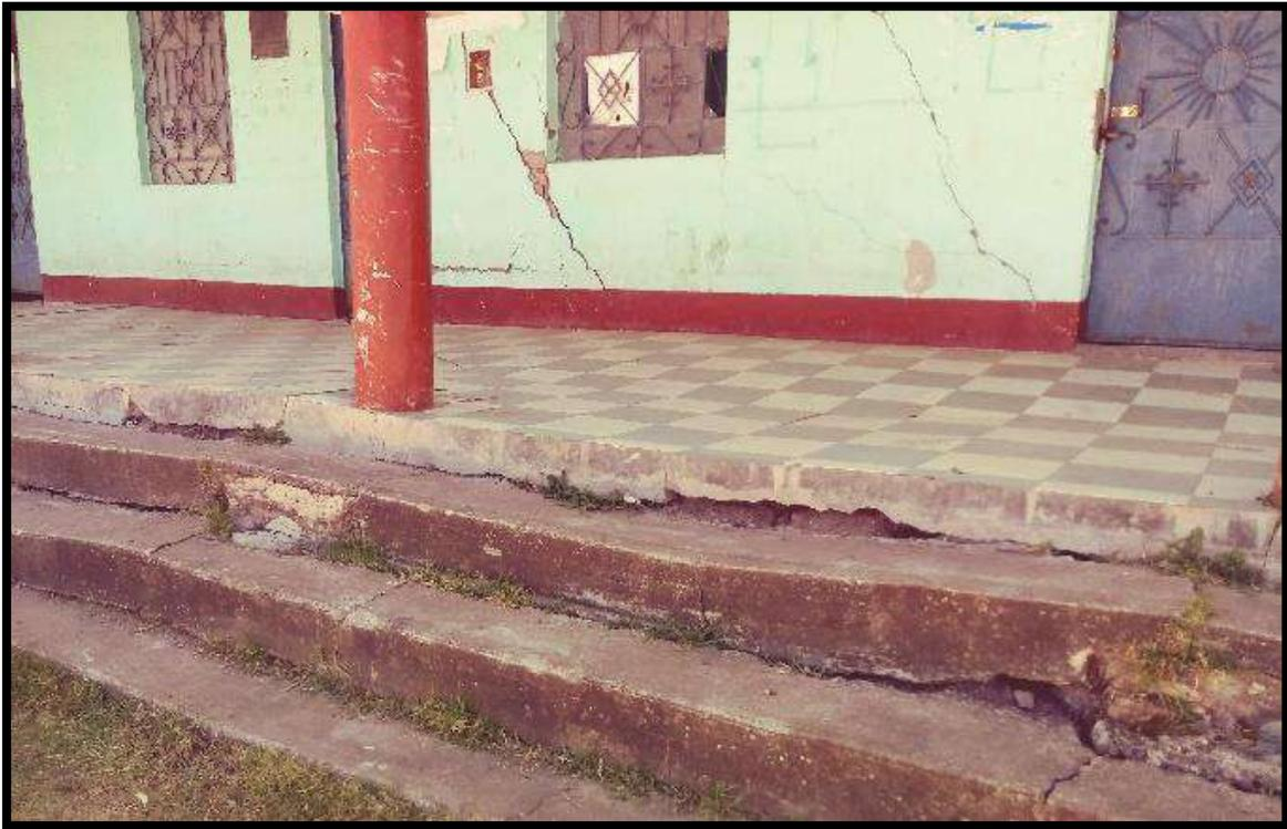
**Imagen N° 13:** Evidencia el daño estructural que sufrió el local de la Municipalidad Distrital de Chincho, afectado por las filtraciones de agua y el efecto geodinámica externo de la zona aérea de la Municipalidad Distrital de Chincho.
