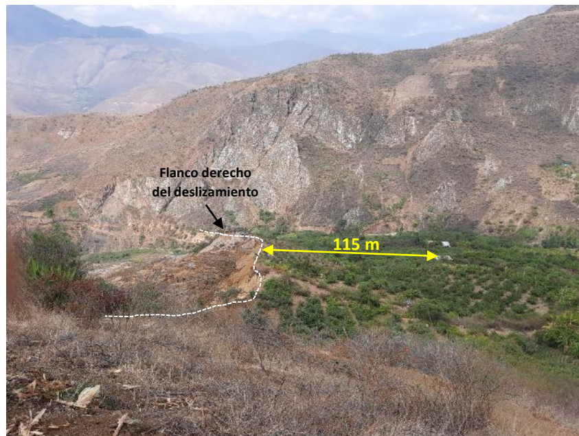
Figura 17. Vista de terrenos de cultivo y viviendas cerca al flanco derecho del deslizamiento
