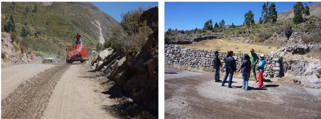
**Figura 04. Fotografía que muestra la sobre carga del talud por regadío irresponsable en la carretera Maca-Cabanaconde-Huambo-Arequipa.**
