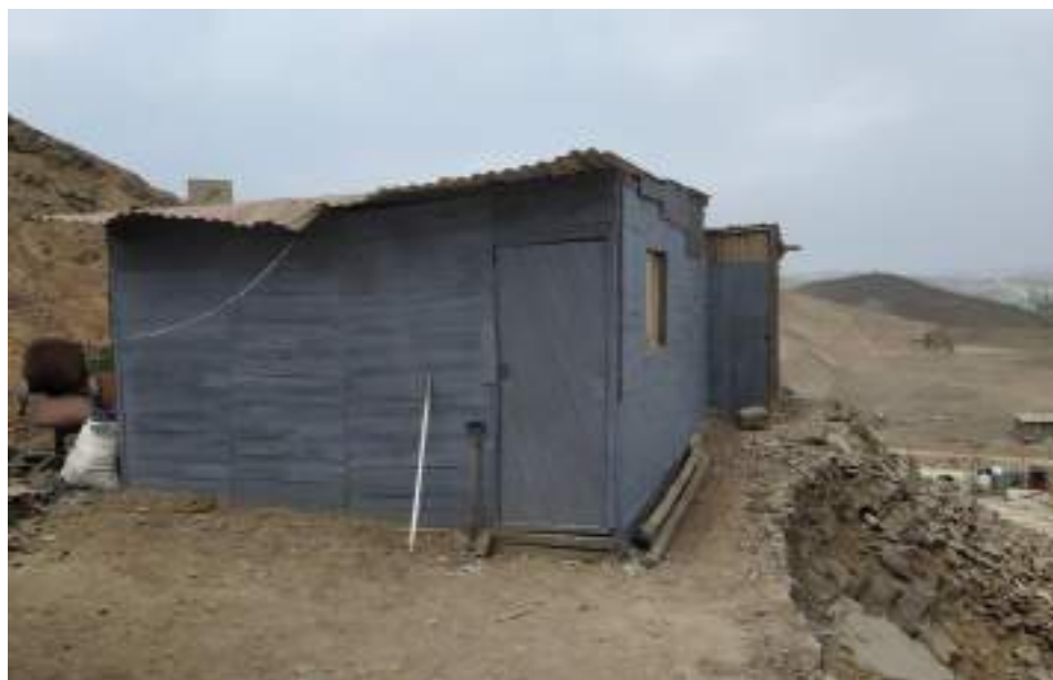
Vivienda de la Mz A' Lt 7 cerca a desnivel de terreno, imagen tomada desde el mismo nivel.
