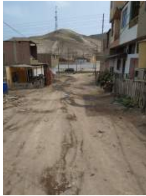
Vista de la Calle 9 hacia el cruce con Carr. Nestor Gambeta, entre las manzanas A y B, de izquierda a derecha respectivamente.
