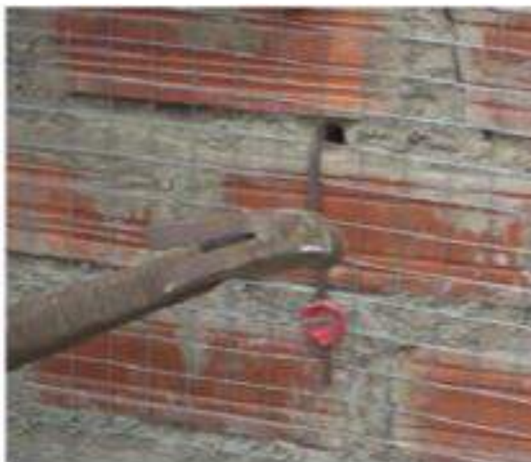
Ilustración 2: Conectores de # 8 dobladas a 90°
