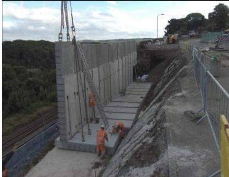
Ilustración 7. Muro de contención de concreto armado
