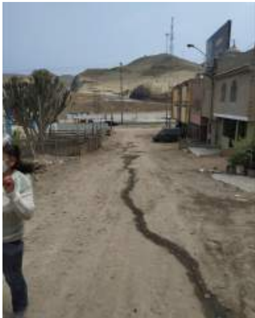
Vista de la Calle 11 hacia el cruce con Carr. Nestor Gambeta, donde la manzana A está del lado derecho.
