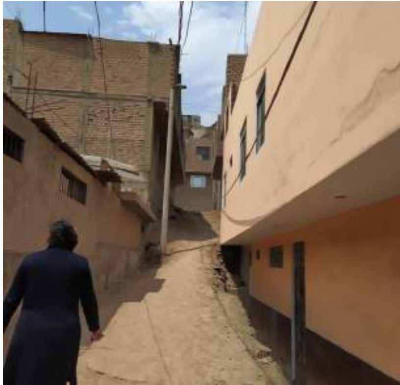
Vista del Pasaje 1 entre las manzanas E y E', de derecha a izquierda respectivamente.
