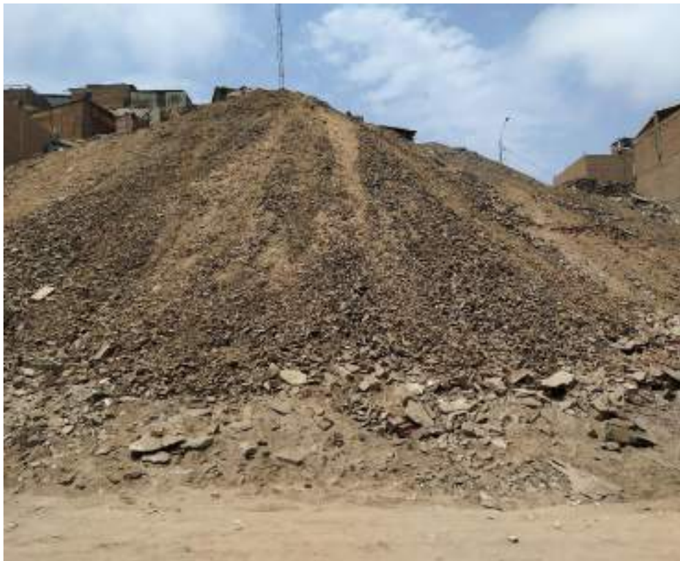
Vista del Parque N° 02 tomada desde la Calle 3. Donde se aprecia la posibilidad de deslizamiento de tierra ante un sismo.
