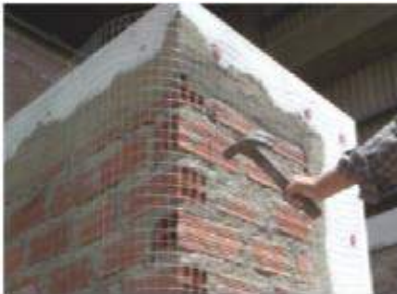
Ilustración 1: Malla electrosoldada en muros de tabiquería
