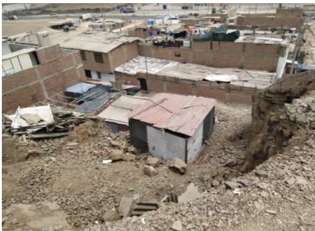
Vista de los lotes 6, 5, 4 y 3, de derecha a izquierda, de la Mz. A' tomadas desde la parte alta.
