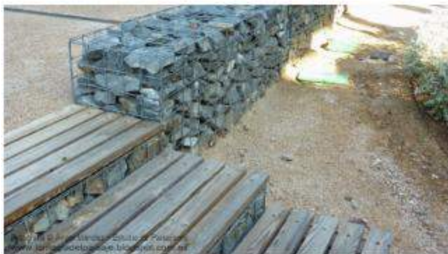
Ilustración 4. Muro de gaviones a implementar.
