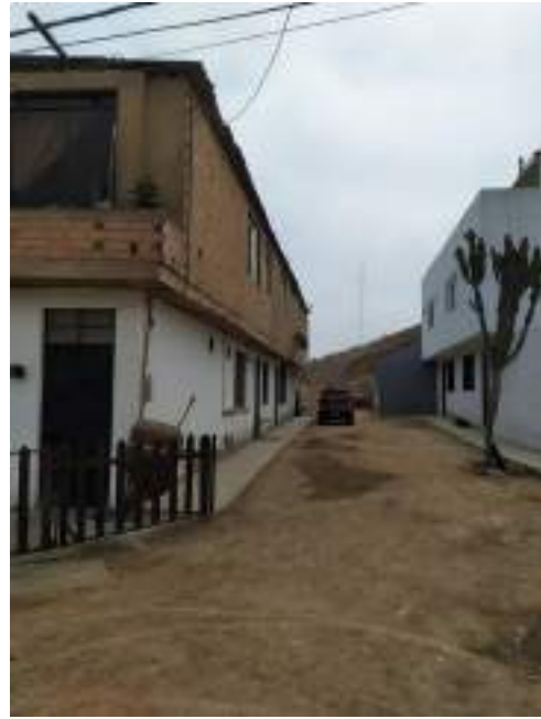
Vista de la Calle 10 entre las manzanas A' y A , de derecha a izquierda respectivamente.
