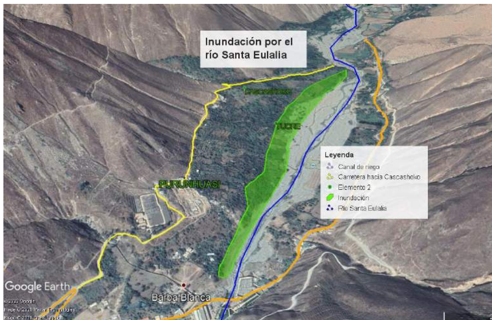
Imagen N° 26: Inundación en el anexo de Barbablanca.
