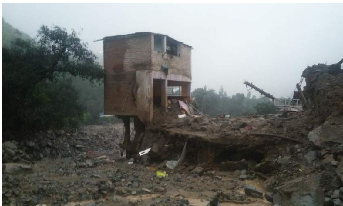
Imagen N° 18: Afectación de viviendas - Barbablanca
