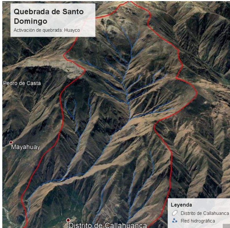
Imagen N° 1: Vista panorámica de la quebrada Santo Domingo
