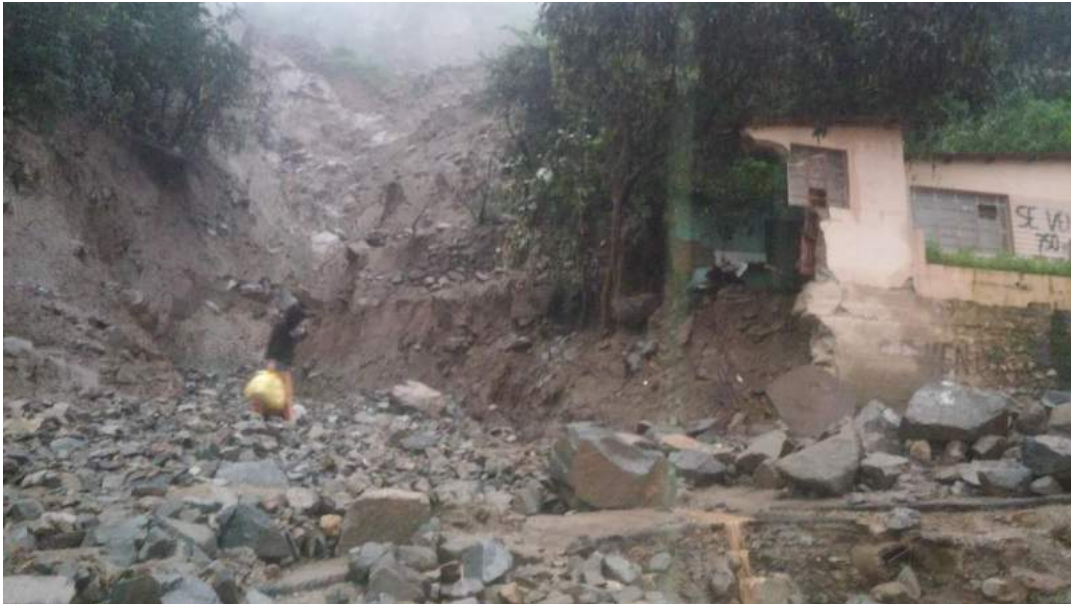
Imagen N° 19: Afectación de la carretera y viviendas - Barbablanca
