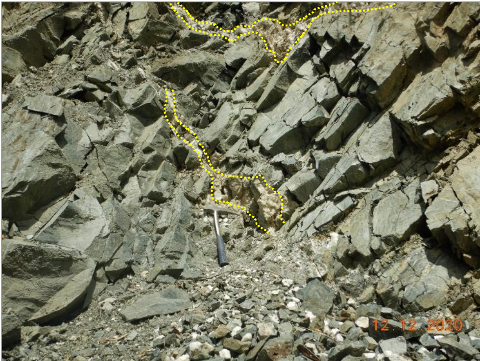
Figura 4. Vista al noroeste del sector Paltaychayoc Alto, esquistos medianamente fracturados, con intrusiones de cuarzo, correspondientes al Complejo Iscaybamba. Con coordenadas UTM (WGS 84): 7580200, 8540114, a 1555 m s.n.m.
