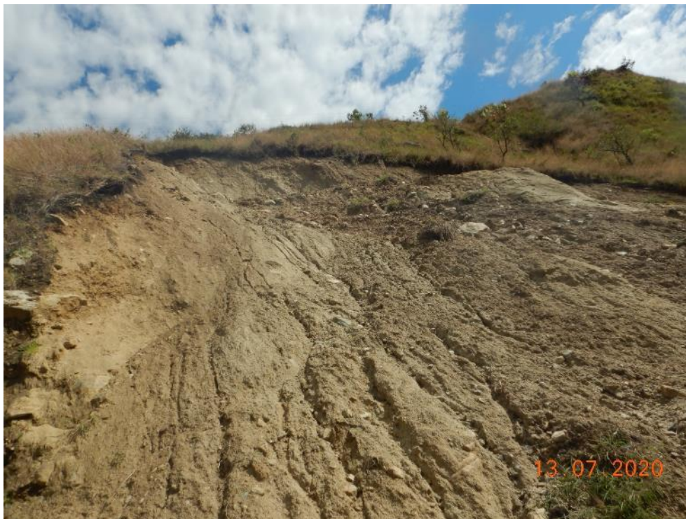
Fotografía 13. Vista del escarpe de un deslizamiento en la ladera sur de la meseta El Potrero, debido a los cortes de talud, coadyuvado por el material y la pendiente del terreno. Con coordenadas UTM (WGS84): 760224 E, 8546164 N a 1586 m s.n.m.
