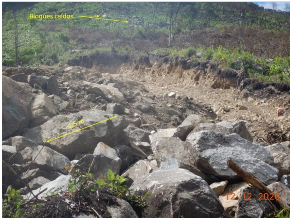
Figura 9. Vista de la zona Damnificados Sahuayaco, en el corte de talud para la instalación de las viviendas se observó bloques de rocas de hasta 1.5 m de diámetro.
