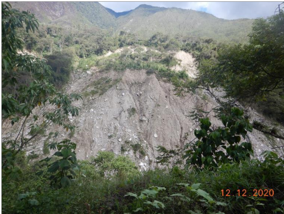
Fotografía 4. Vista de la subunidad de depósito de deslizamiento (V-dd) en la margen derecha del río Salkantay. Con coordenadas UTM (WGS 84): 758196 E, 8538385 N a 1944 m s.n.m.
