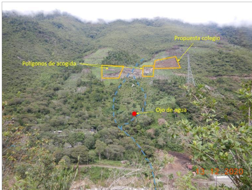
Figura 10. Vista del polígono Damnificados Sahuayaco 1 y 2 y la propuesta de la Institución Educativa, en la parte media se aprecia marcas de un cauce intermitente y en la parte baja un ojo de agua. Coordenadas UTM (WGS 84): 756331 E, 8535868 N a 2239 m s.n.m.
