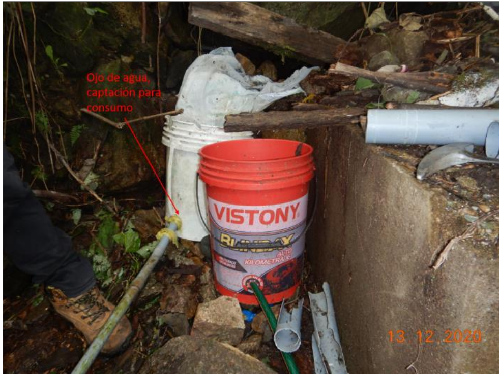
Figura 11. Vista de captación de ojo de agua para el consumo humano. Con coordenadas UTM (WGS84): 756405 E, 8535801 N, a 2186 m s.n.m.
