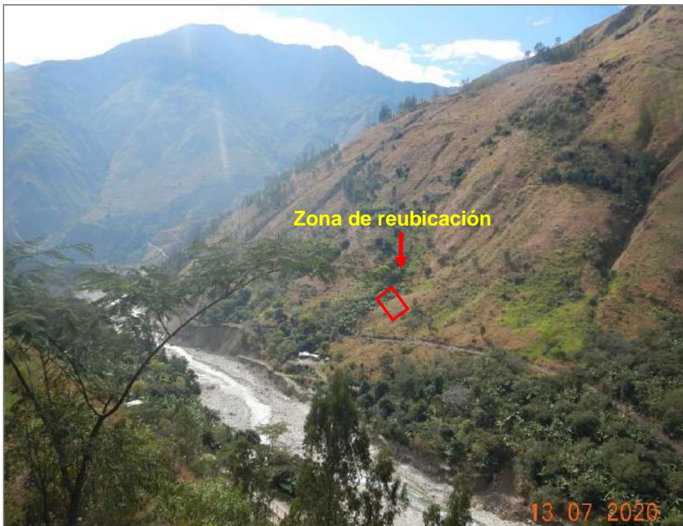
Figura 2. Vista panorámica del terreno de reubicación propuesto para el sector Limonpata.
