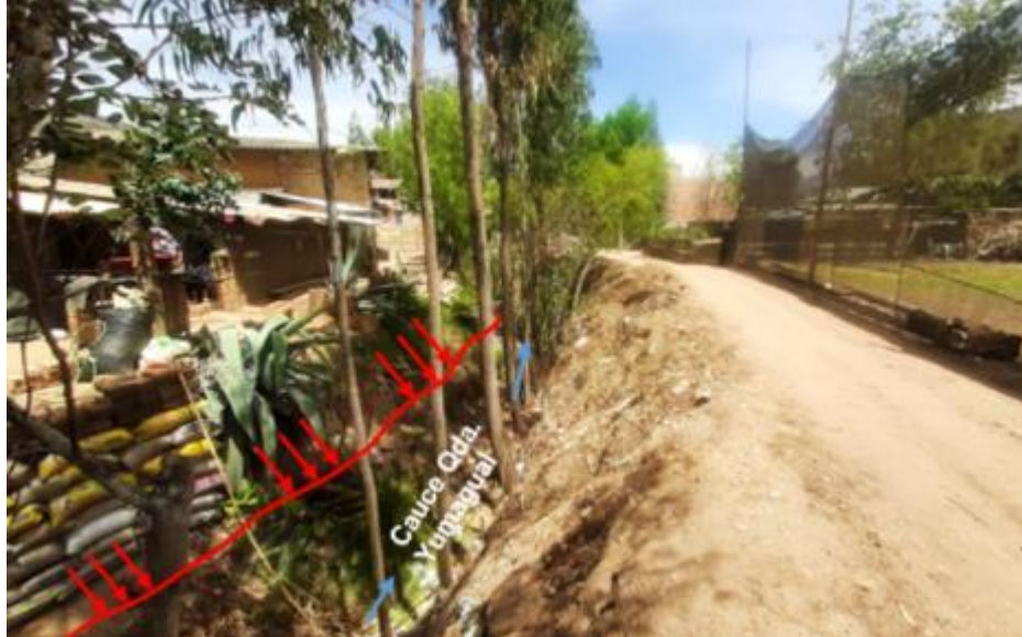
Figura 26. Erosión fluvial en el curso bajo de la quebrada Yumagual, cuyo ancho de cauce se ha reducido a 1.5 metros aproximadamente. Nótese la colocación de sacos con arena para disminuir el proceso erosivo (775888.30 / 9204735.32).
