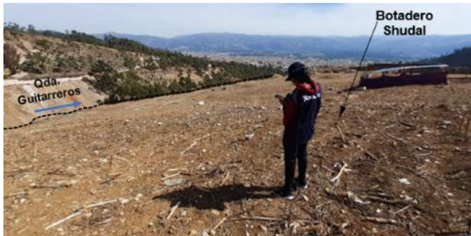
Figura 10: Vista del botadero Shudal, ubicado hacia la margen derecha de la quebrada Guitarreros.
