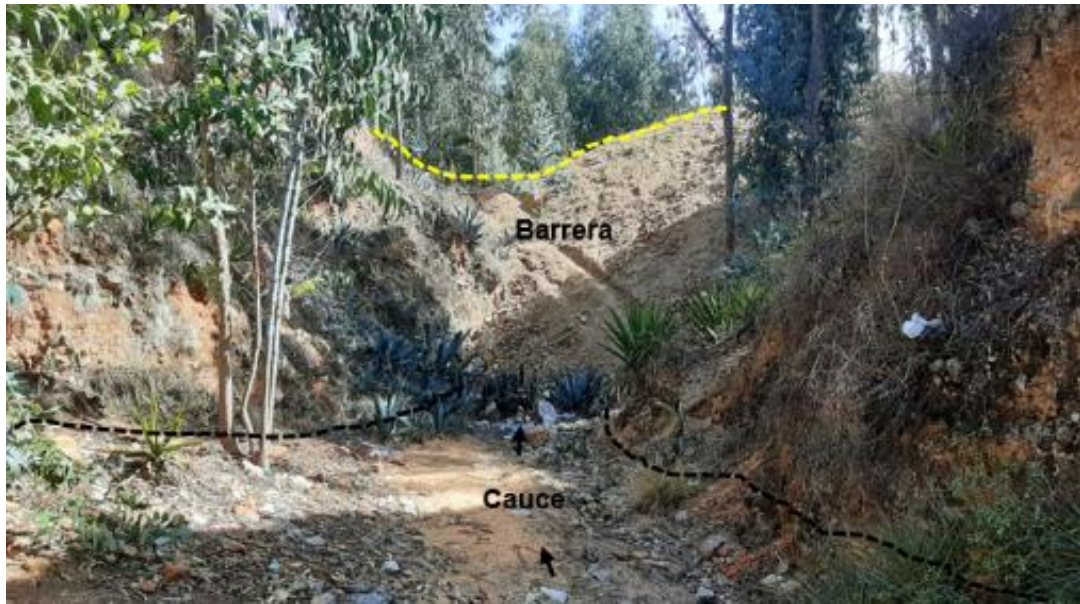
Figura 34. Vista del cauce de un afluente de la quebrada Yumagual (775759.07 E /9203735.97). Nótese, que la construcción de una trocha carrozable ha cerrado el curso de la quebrada con una barrera de desmonte.
