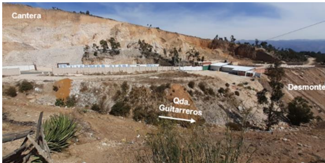
Figura 28. Peligro por erosión fluvial en la quebrada Guitarreros. En la margen izquierda se evidencia la acumulación de abundante desmorte en las laderas y cauce de la quebrada (774996.22 / 9203518.97).
