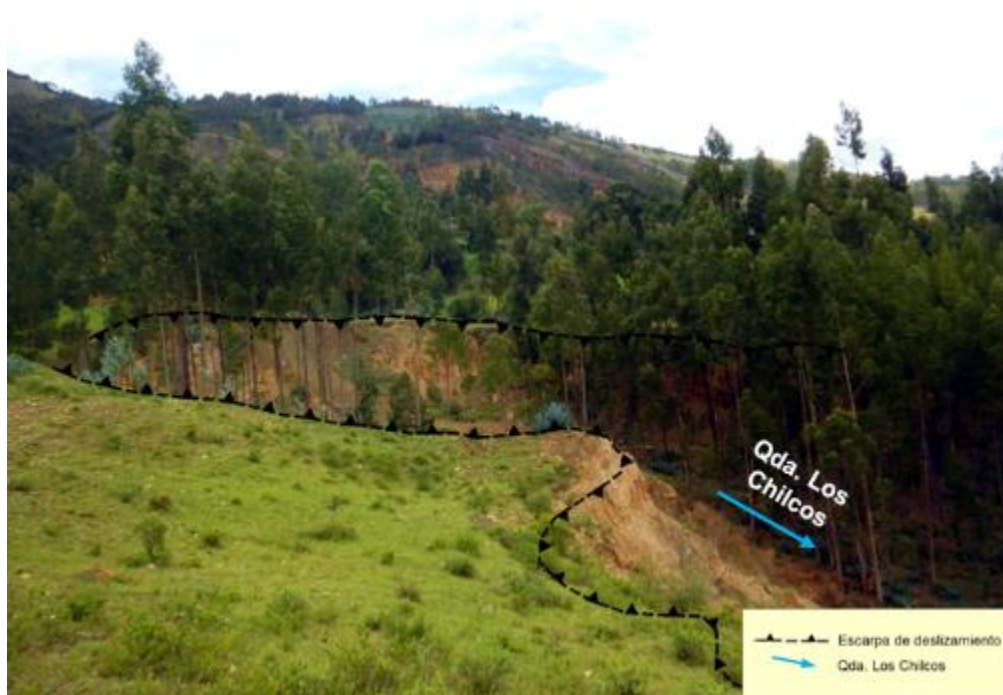
Figura 18: Deslizamiento en ambas márgenes de la quebrada Los Chilcos en su curso medio (774350.67E / 9204233.11 N).
