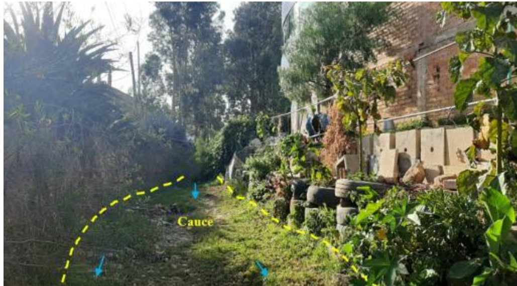
Figura 32. Curso inferior de la quebrada Los Chilcos, en donde se observa la construcción de vivienda en sus riberas. (777742.85 E / 9204802.24 N).
