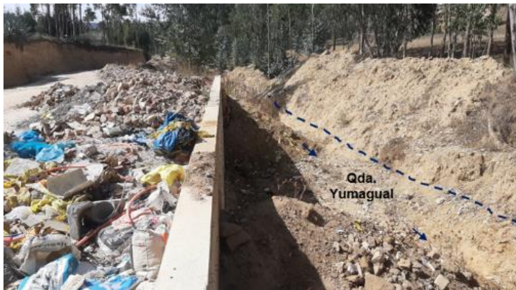
Figura 33. Curso inferior de la quebrada Yumagual, colmatada con abundantes residuos sólidos.
