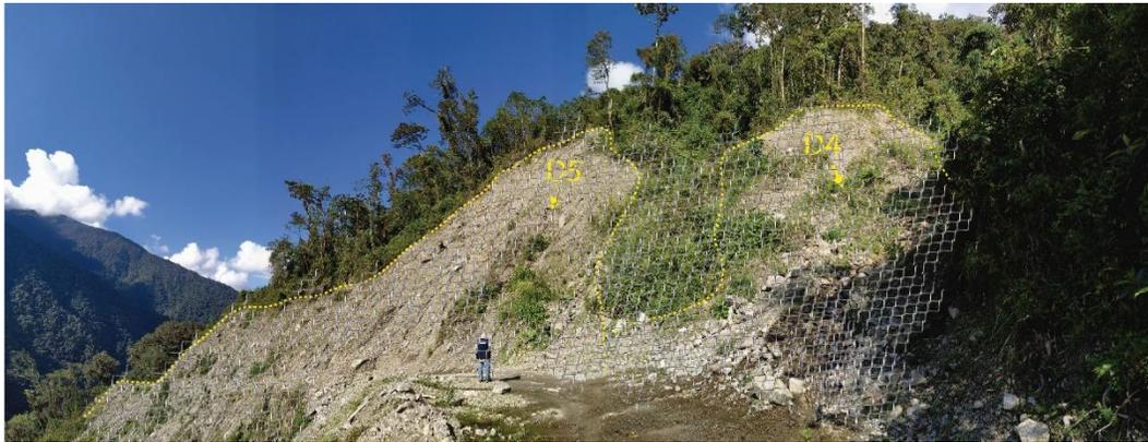
**Figura 38.** Ejemplo de enmallado en taludes.
