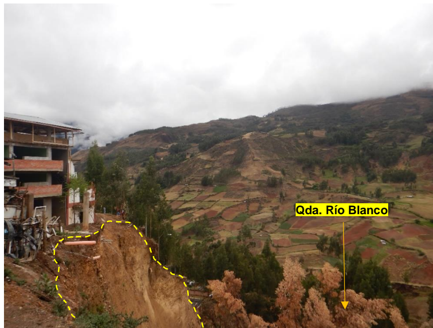
Figura 10. Procesos de erosión de laderas a manera de cárcavas, en la margen izquierda de la quebrada Río Blanco. Se pueden observar viviendas ubicadas muy proximas al escarpe del deslizamiento (línea punteada) y que podrían ser afectadas. Coordenadas UTM WGS84: 246901E; 9084871N.
