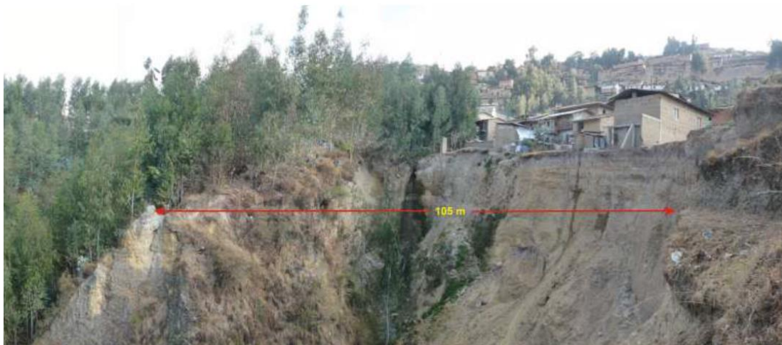
Figura 12. Procesos de erosión en cárcavas, en el sector de quebrada Río Blanco.
