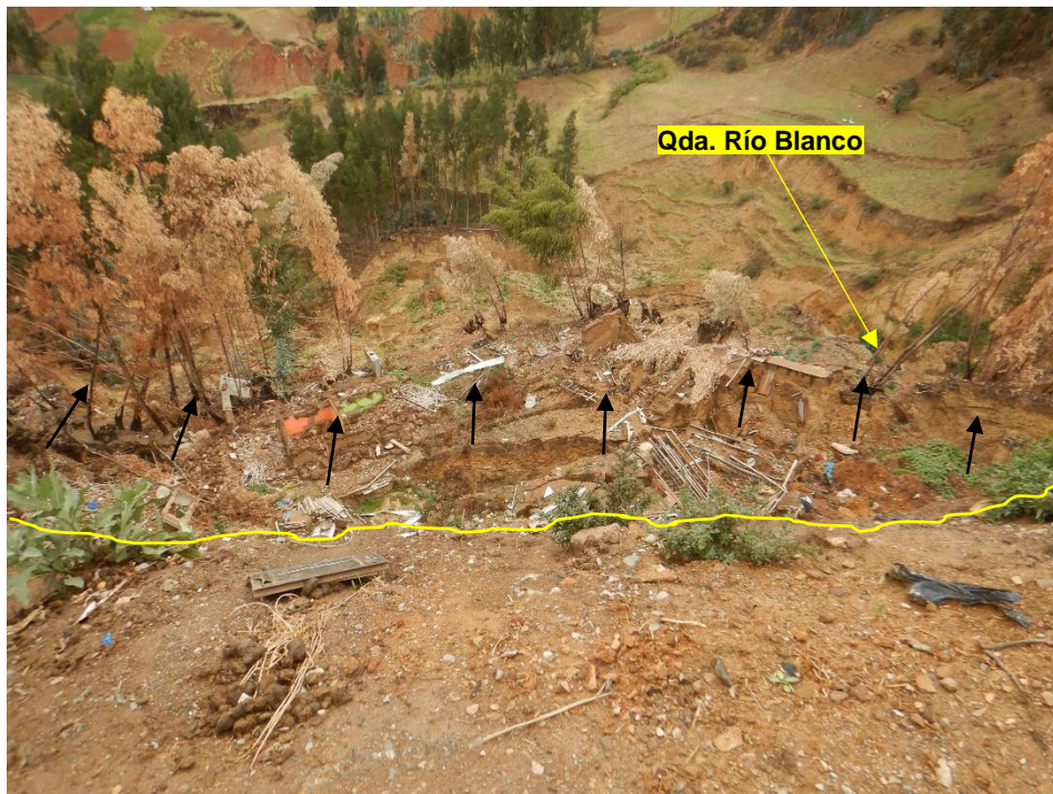
Figura 18. Escarpe principal del deslizamiento activo (línea amarilla) identificado en las urbanizaciones Ortecho y California. Se observa el material deslizado (las
