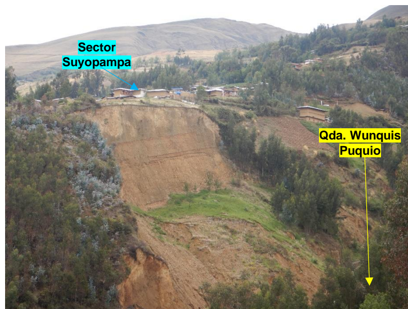
Figura 17. Vista del sector Suyopampa, en el cual existen viviendas que podrían ser afectadas por el deslizamiento activo identificado. Coordenadas UTM WGS84: 247215E; 9083514N.
