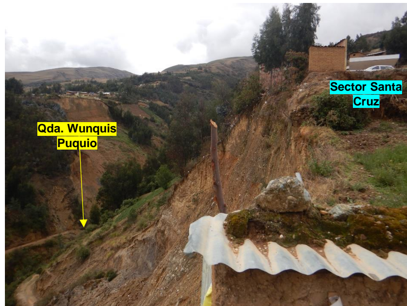
Figura 16. Viviendas del sector Santa Cruz ubicadas próximas al deslizamiento activo y que podrían ser afectadas. Coordenadas UTM WGS84: 247150E; 9083980N.
