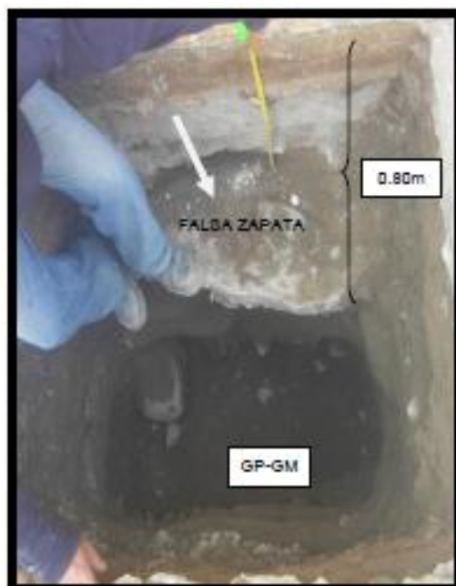
FOTO N° 4 VISTA DEL CIMIENTO DONDE SE OBSERVA FALSA ZAPATA Y EL ENSAYO DE DENSIDAD NATURAL EN EL FONDO DE LA CALICATA
