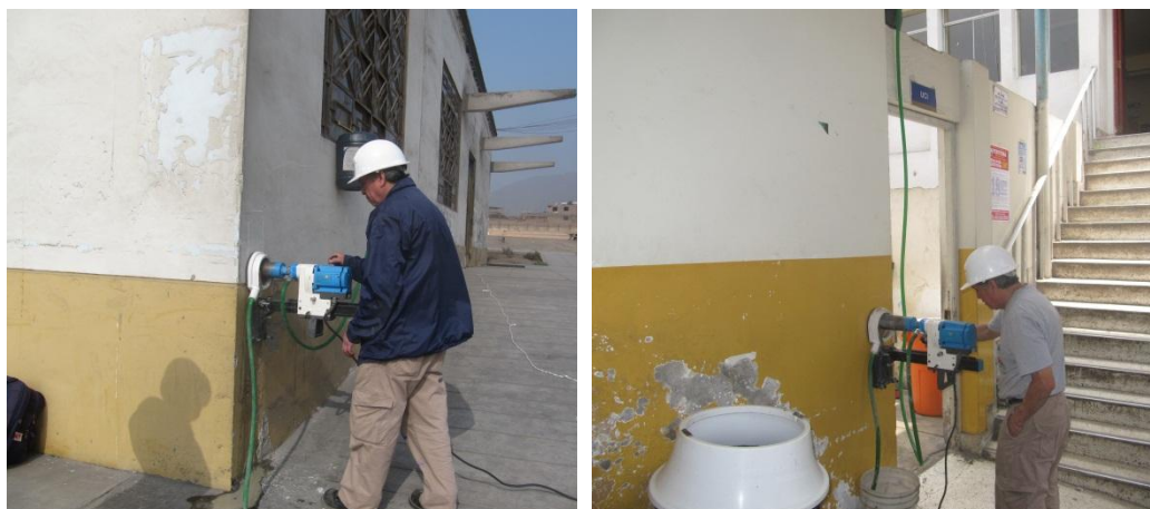
Foto 1. Extracción de núcleos de concreto
