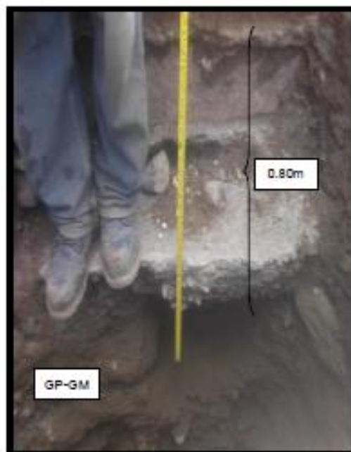
FOTO N° 3 VISTA DEL CIMIENTO ENCOTRADO, DONDE SE OBSERVA LA PROFUNDIDAD DE LA CIMENTACION Y EL MATERIAL
