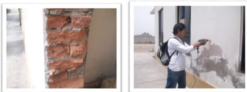
Figura 27. Edificaciones de albañilería
