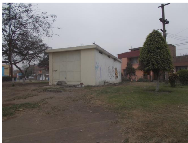
Figura 59. Caseta de pozo en parque público
