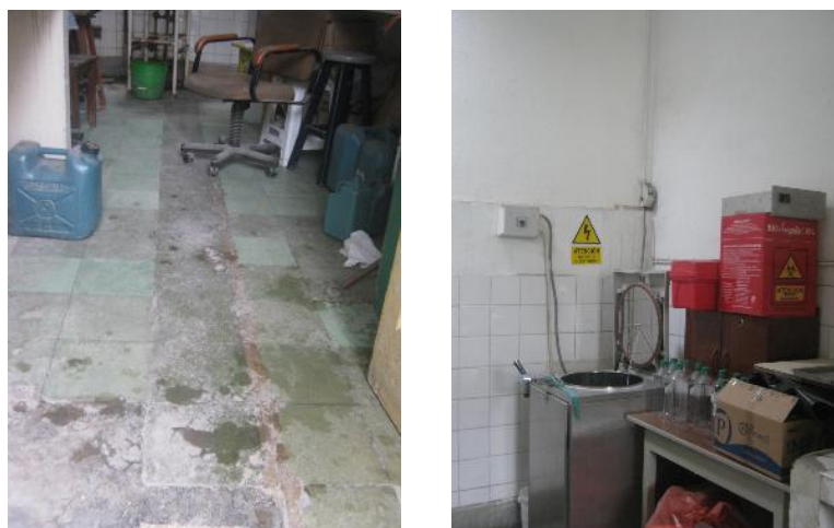
Figura 56. Central de Esterilización se encuentra en proceso de Remodelación
