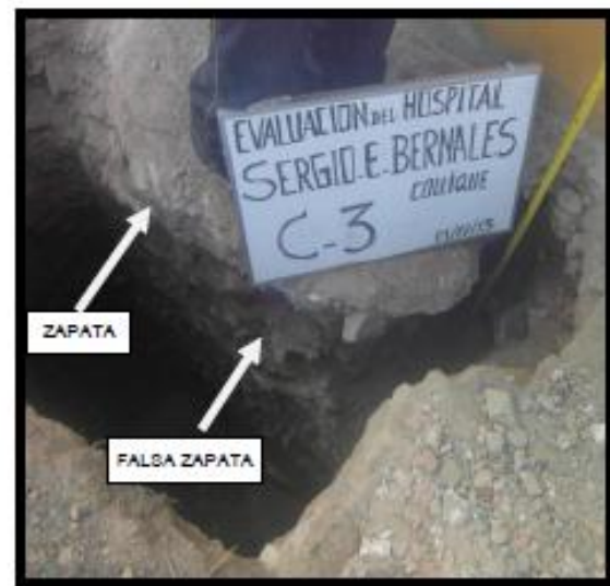
FOTO N° 8 VISTA DE AUSCULTACION DEL CIMENTO DONDE SE OBSERVA LA FALSA ZAPATA Y LA ZAPATA APOYADOS SOBRE EL MATERIA (SP-SM) A (GP-GM)
