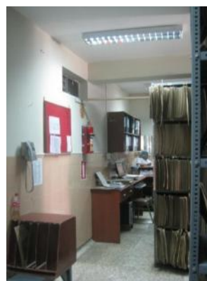
Figura 32. En la mayoría de los casos, los mobiliarios se encuentran en regular estado y no presentan sistema de anclaje o fijación ya que son tipo escritorio sin sistema de ruedas ni frenos
