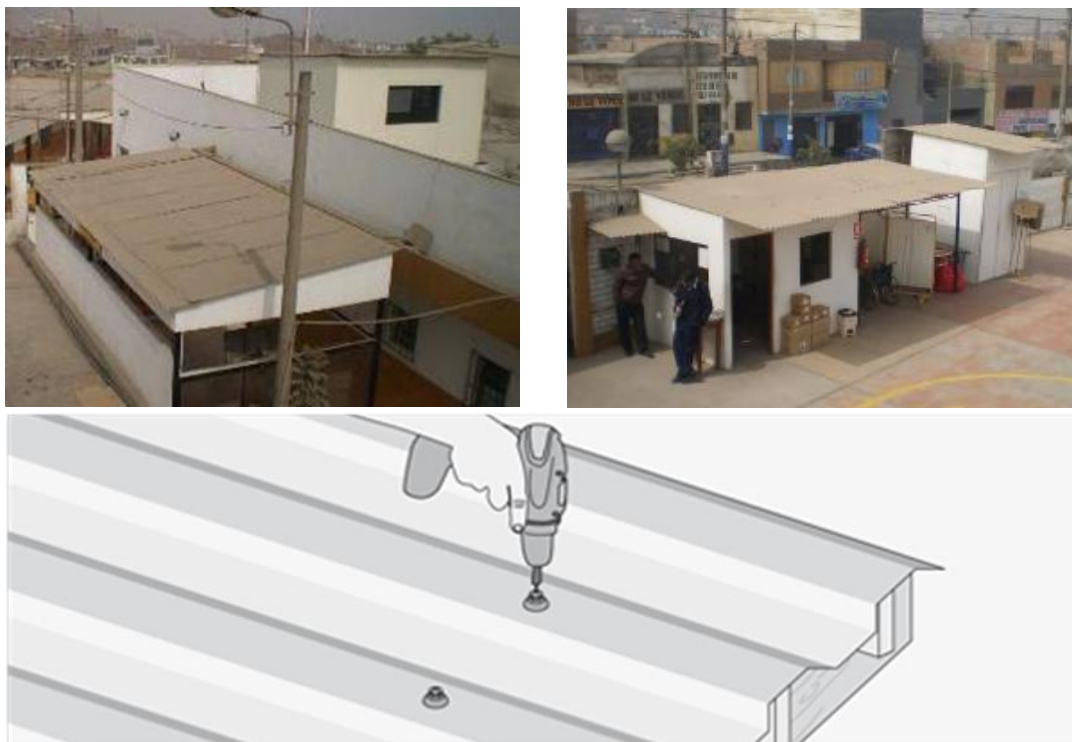
Figura 6. Techos ligeros que deben estar sujetos adecuadamente a fin evitar caídas o desprendimientos
