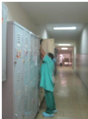
Figura 49. En el corredor de Centro Obstétrico se encuentran armarios no sujetos adecuadamente con riesgo de caída ante movimientos sísmicos.
