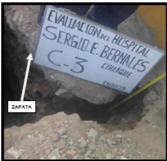
FOTO N° 8 VISTA DE AUSCULTACION DEL CIMENTO DONDE SE OBSERVA LA FALSA ZAPATA Y LA ZAPATA APOYADOS SOBRE EL MATERIA (SP-SM) A (GP-GM)
