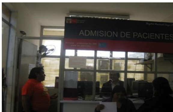
Figura 44. Los paneles divisorios existentes son de material prefabricado, también son elementos importantes a considerar en la vulnerabilidad en casos de sismo. Los existentes se encuentran en regular estado de conservación, con vidrios crudos que pueden afectar las rutas de evacuación.
