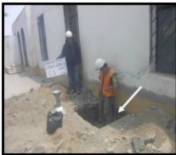
FOTO N° 1 UBICACIÓN DE AUSCULTACION DE LA CIMENTACION POR MEDIO DE CALICATA C-1
