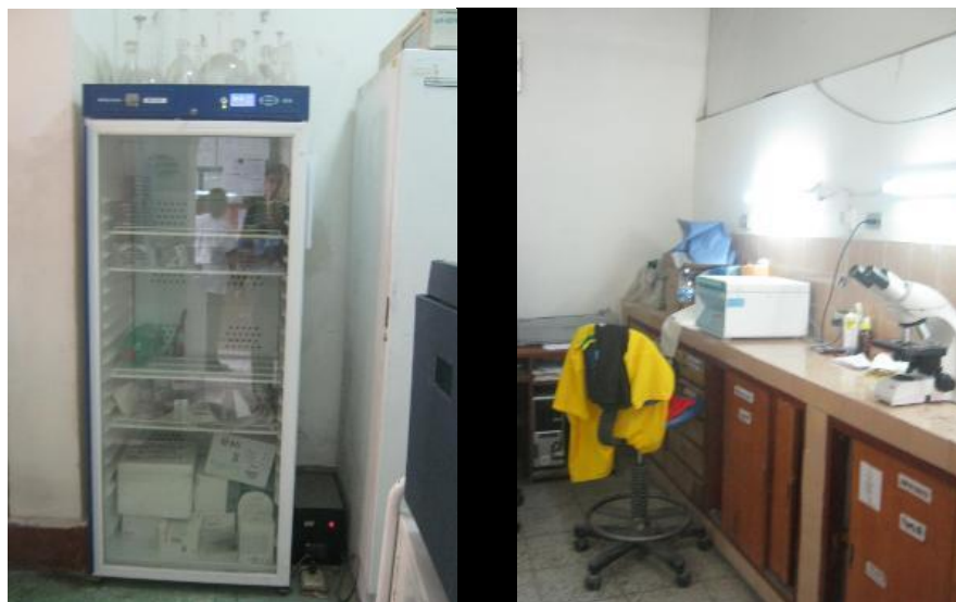
Figura 55. En laboratorio equipos colocados con riesgo de volcamiento
