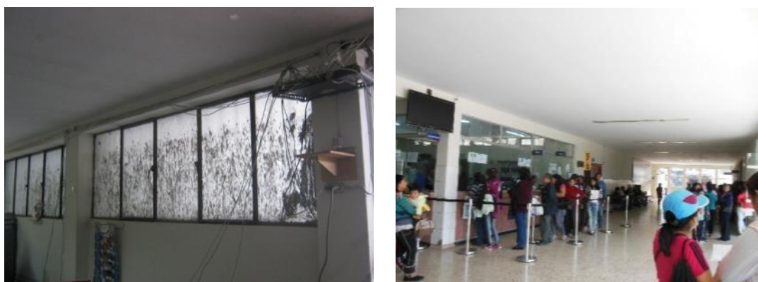
Figura 39. La presencia de grandes vanos y ventanales es materia importante a analizar en el cumplimiento de las normas de seguridad. En la mayoría de los ambientes, es notoria la presencia del uso de vidrio crudo.
