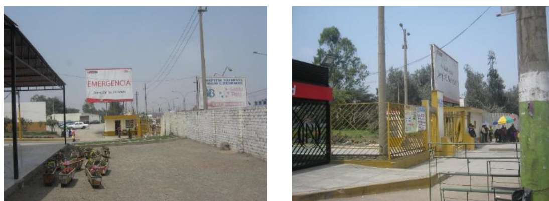
Figura 40. Los elementos de cierre como los muros de ladrillo se encuentran en regular estado de conservación, en algunos sectores denota filtración y desgaste del ladrillo por la falta de mantenimiento. Las rejas de hierro denotan seguridad en su estructura; sin embargo, la presencia de corrosión en algunos sectores son un peligro latente al debilitamiento de los mismos.
