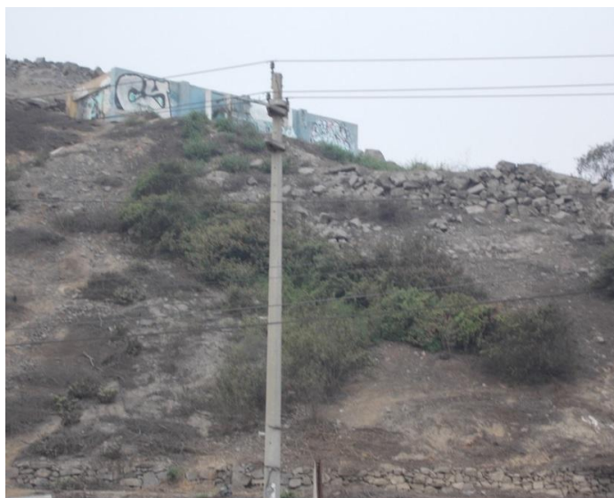
Figura 61. Vegetación creada por fugas de agua
