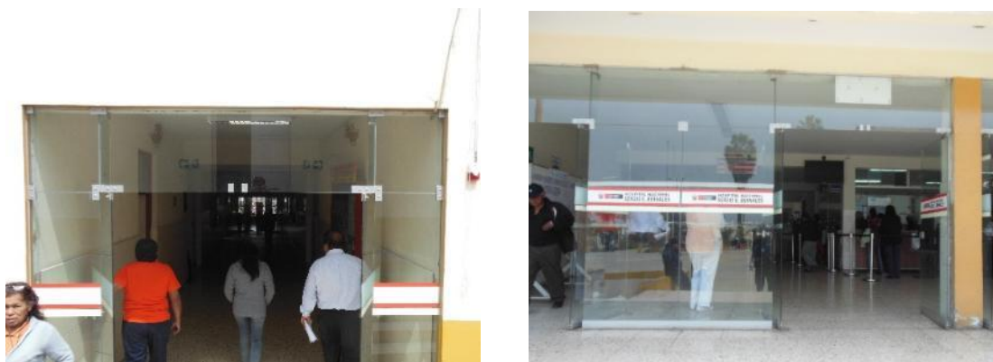
Figura 38. Existen puertas de cristal y el sistema de apertura es óptimo para los casos de evacuación, denotan seguridad.
