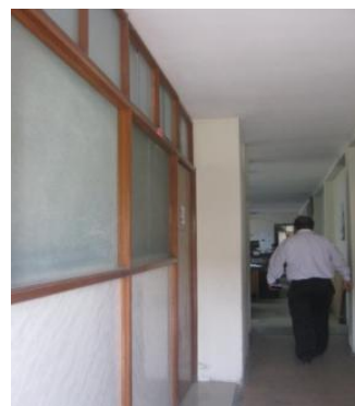
Figura 44. Los paneles divisorios existentes son de material prefabricado, también son elementos importantes a considerar en la vulnerabilidad en casos de sismo. Los existentes se encuentran en regular estado de conservación, con vidrios crudos que pueden afectar las rutas de evacuación.
