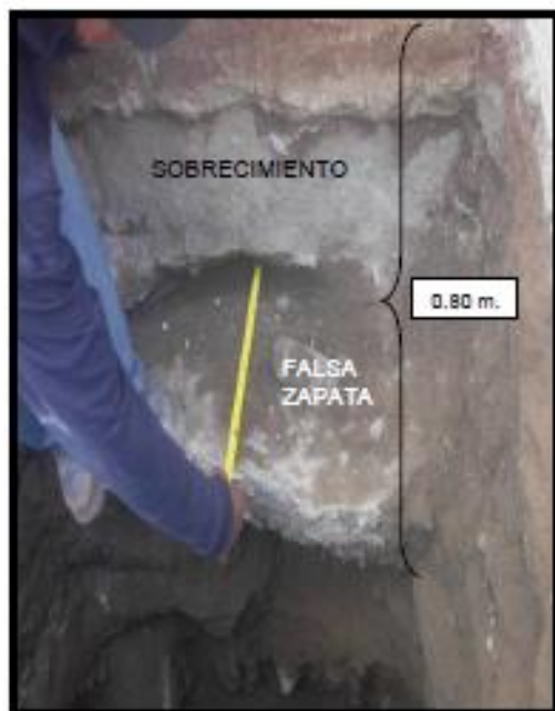
FOTO N° 3 VISTA DEL CIMIENTO ENCOTRADO, DONDE SE OBSERVA LA PROFUNDIDAD DE LA CIMENTACION Y EL MATERIAL
