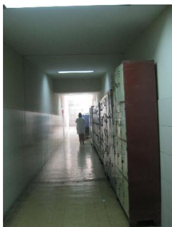
Figura 49. En el corredor de Centro Obstétrico se encuentran armarios no sujetos adecuadamente con riesgo de caída ante movimientos sísmicos.
