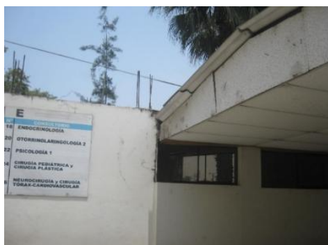
Figura 45. Es notorio el peligro inminente por el desprendimiento de algunos paneles del falso cielo raso; en suma, es producto de la deficiencia en la instalación, el pandeo producto de la humedad y la falta de mantenimiento
