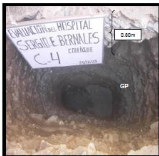
FOTO N° 10 VISTA DEL CIMENTO CORRIDO Y EL MATERIAL.
