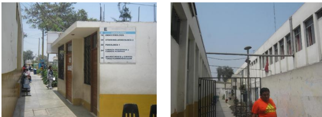
Figura 42. Las circulaciones externas deben encontrarse libre de obstáculos o de cualquier elemento cobertor o publicitario, la presencia de estos elementos provocaría un siniestro en casos de no estar sujetos debidamente.
