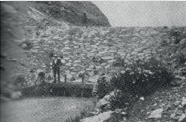
Foto 3. Conductos de descarga cubiertos y dique reconstituido.
