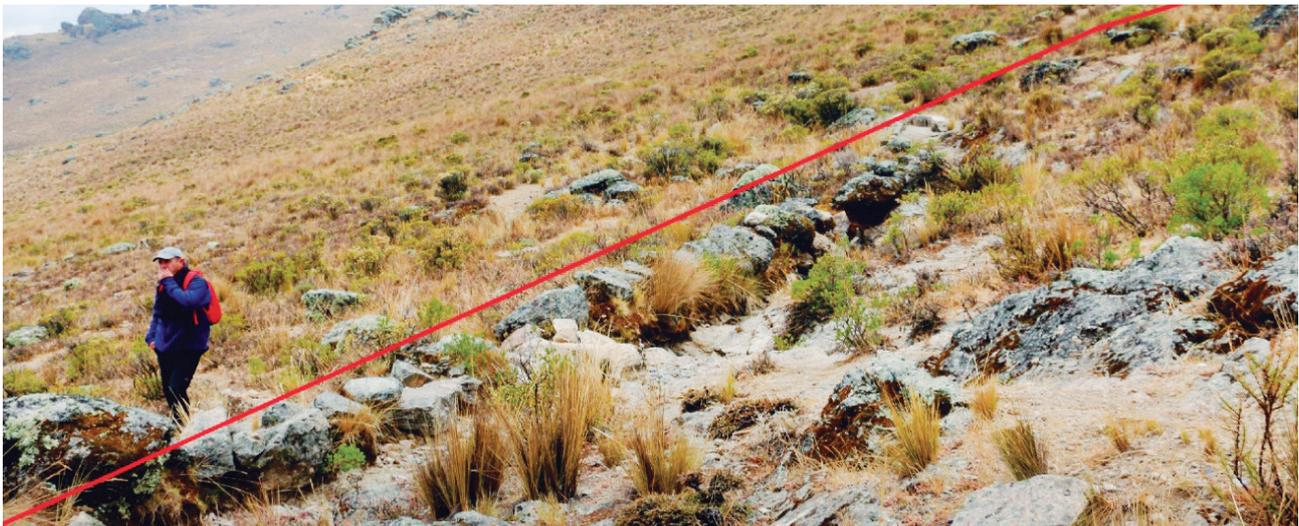
Foto 8. El canal registrado es uno de los llamados de 1°, 2° y 3° orden, es decir, los que se construyeron sobre terrenos naturales con fuerte pendiente y enrocados
