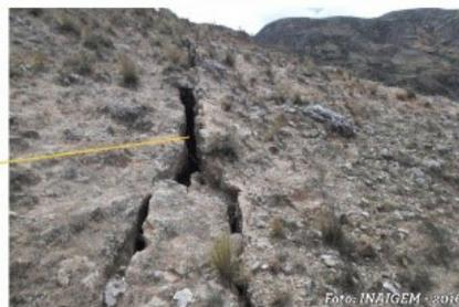
Grietas de separación en la parte alta del deslizamiento
