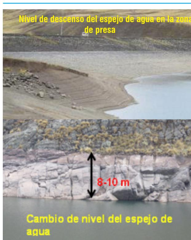
Figura 4. Represa Yuracmayo (capacidad total, 48 Mm<sup>3</sup>). Nivel de descenso del espejo de agua en setiembre de 2016
