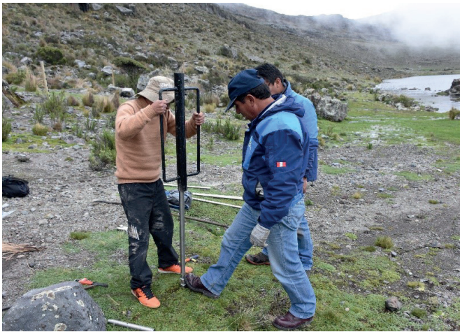
Foto 7. Instalación del piezómetro
