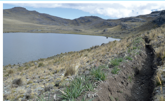
Foto 10. Zanjás de infiltración
