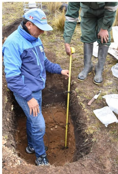
Foto 5. Instalación de sensores de humedad del suelo
