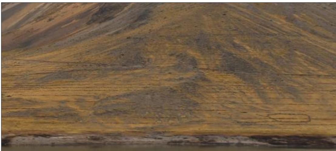
Fotografía N° 15: Zanjas de infiltración en la margen derecha de la represa Yuracmayo.
