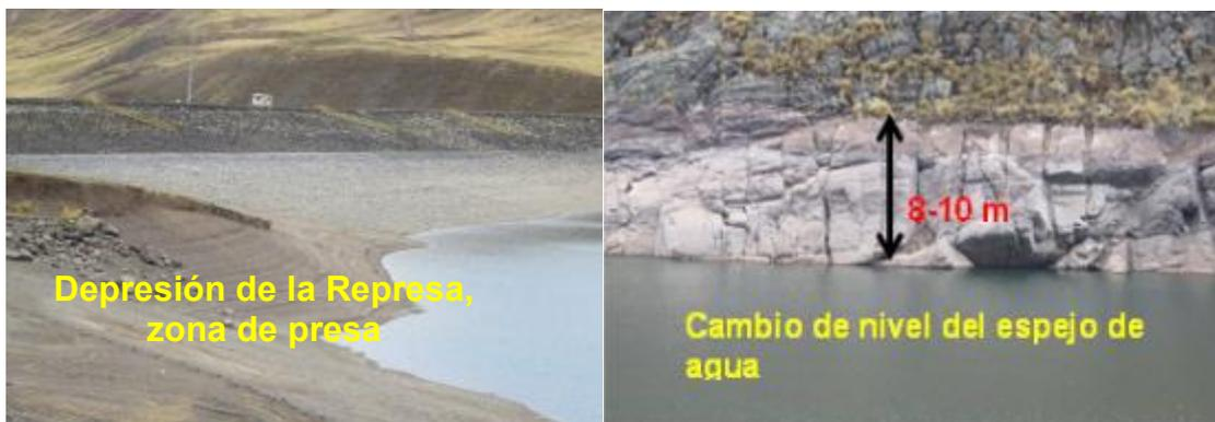
**Fotografía N° 13:** Vista izquierda se observa la presa de Yuracmayo con amplia zona depresionada por disminución en el aporte hídrico desde el glaciar Sullcón y Pancacoto. A la derecha, diferencia de nivel del espejo de agua en la represa, cuya línea superior indica la máxima capacidad de almacenamiento (48 Mm<sup>3</sup>).
