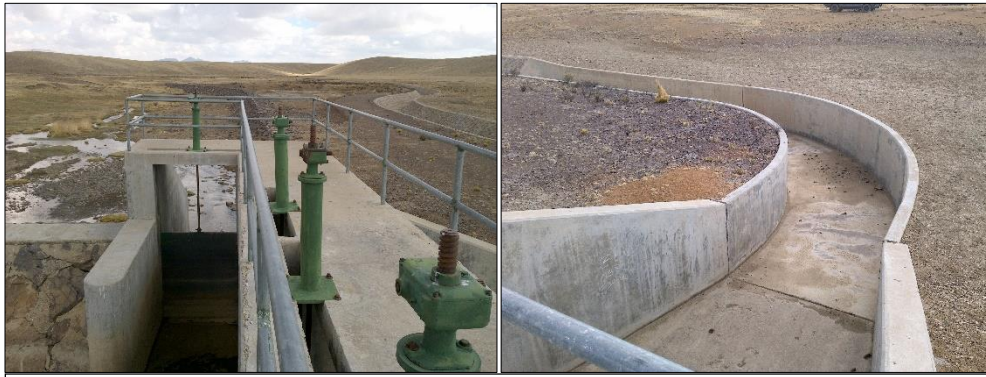
Fotografía N° 10. Bocatoma aguas abajo de la laguna (izquierda) y canal de desvío (derecha).
